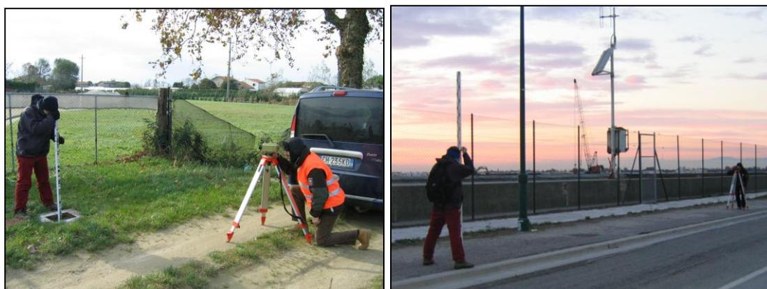
Fig. 4.8 - Operazioni di livellazione
