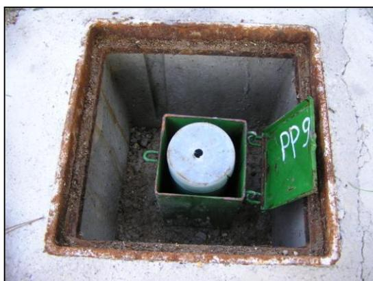
Fig. 7.5: Foro di ventilazione del piezometro.
