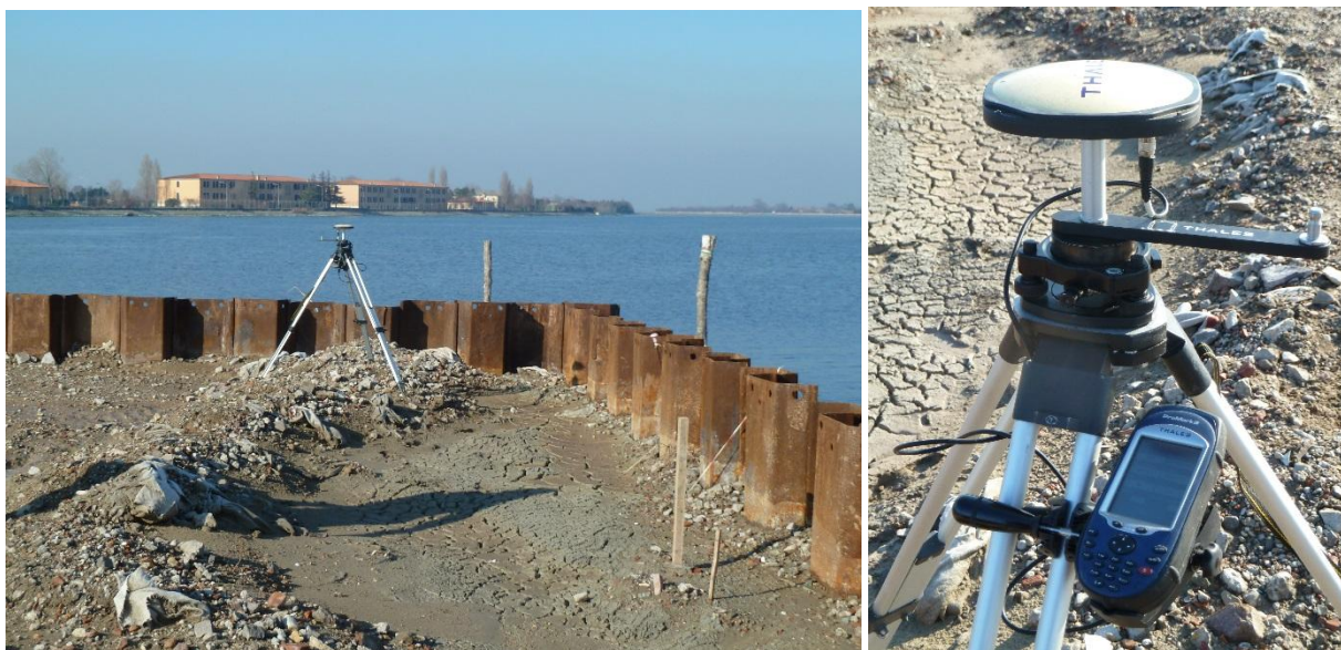
Figura 14. Caposaldo locale temporaneo presso l'isola della teleguidata di Lido (sinistra) con dettaglio del ricevitore Ashtech Promark 3 (destra).
