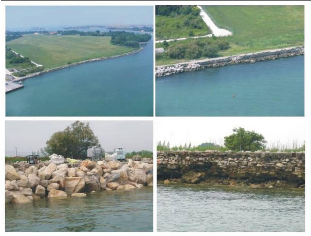
Figura 3.17 - Rilievi fotografici della spalla della diga sud ai margini dell'aeroporto Nicelli.
