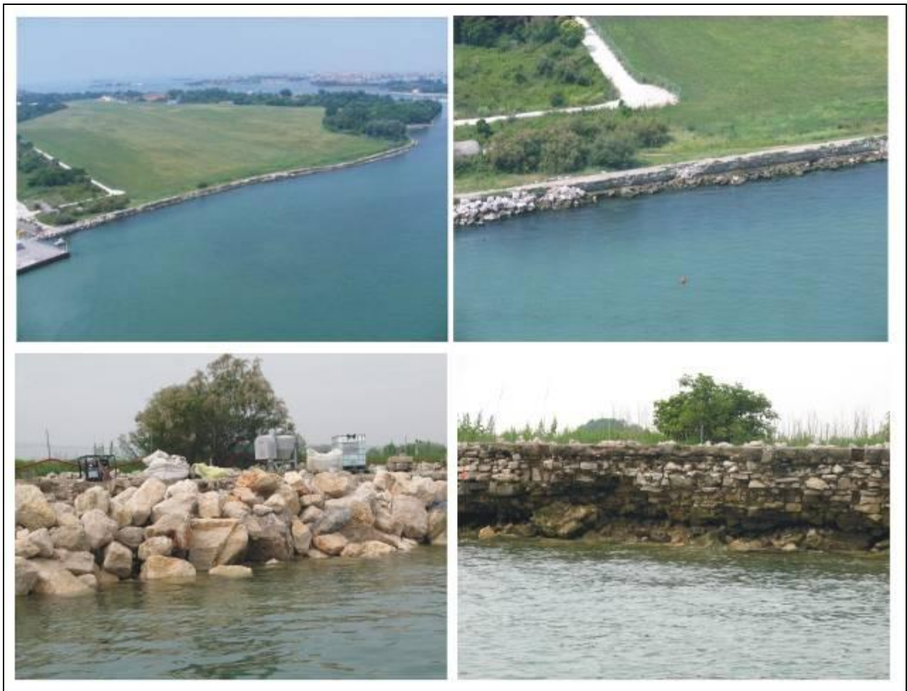
Figura 3.20 –Rilievi fotografici della spalla della diga sud ai margini dell'aeroporto Nicelli.
