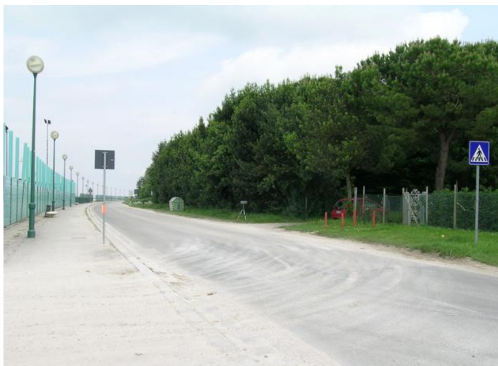
Fig. 2.15 - Manto stradale ricoperto di polvere a grana fine proveniente dall'area di cantiere.
