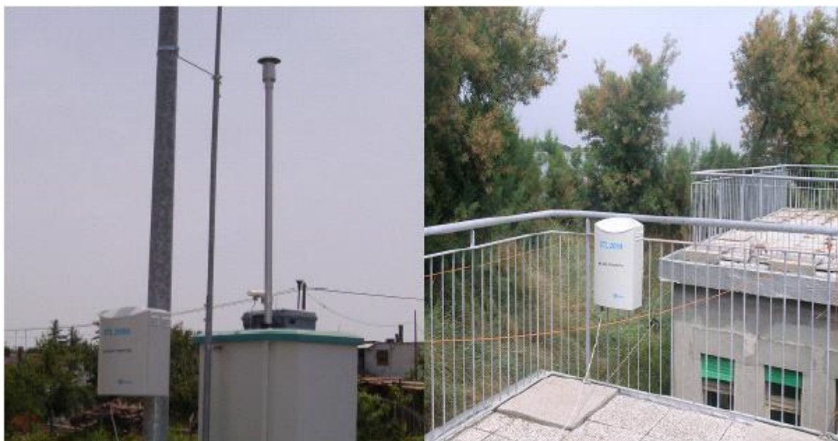
Fig. 4.1 – Stazione misura dei gas ETL2000 a Punta Sabbioni (sinistra) e a Malamocco (destra)
