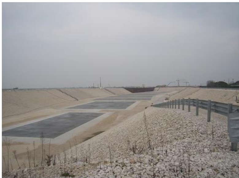
Fig. 2.1 - Tura a Punta Sabbioni. Le autobetoniere percorrono la strada interna laterale (a destra)
