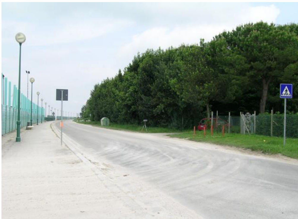
Fig. 4.16 - Manto stradale ricoperto di polvere a grana fine proveniente dall'area di cantiere.
