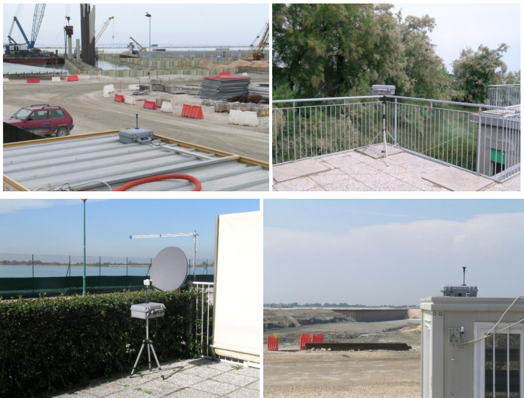
Fig. 2.10 - Monitoraggio con il DustTrak a Malamocco (in alto) e a Punta Sabbioni (in basso)
