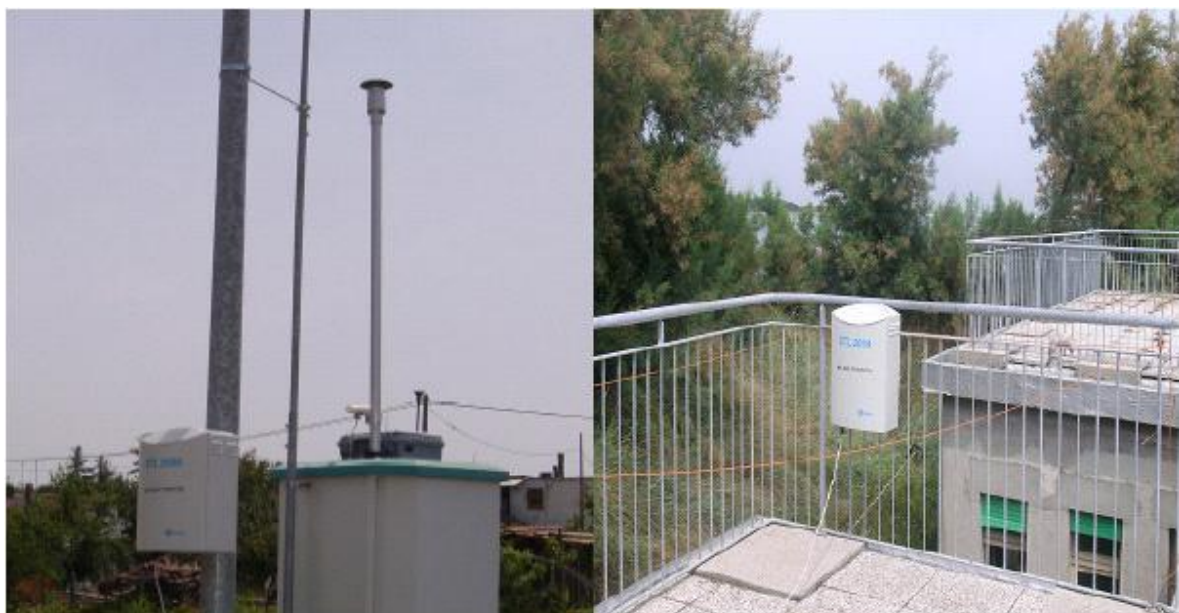
Fig. 4.2 - Stazione misura dei gas ETL2000 a Punta Sabbioni (sinistra) e a Malamocco (destra)
