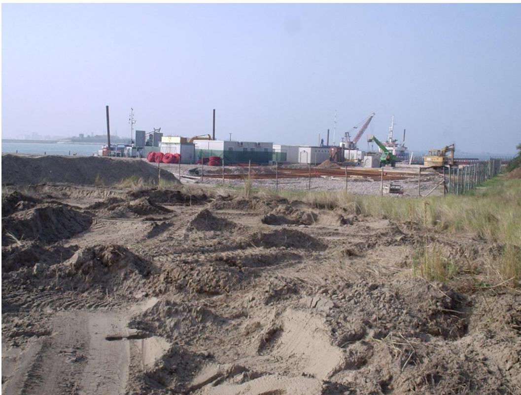
Fig. 2.2 Accumuli di terreno nell'area monitorata, esterna e confinante con il cantiere
