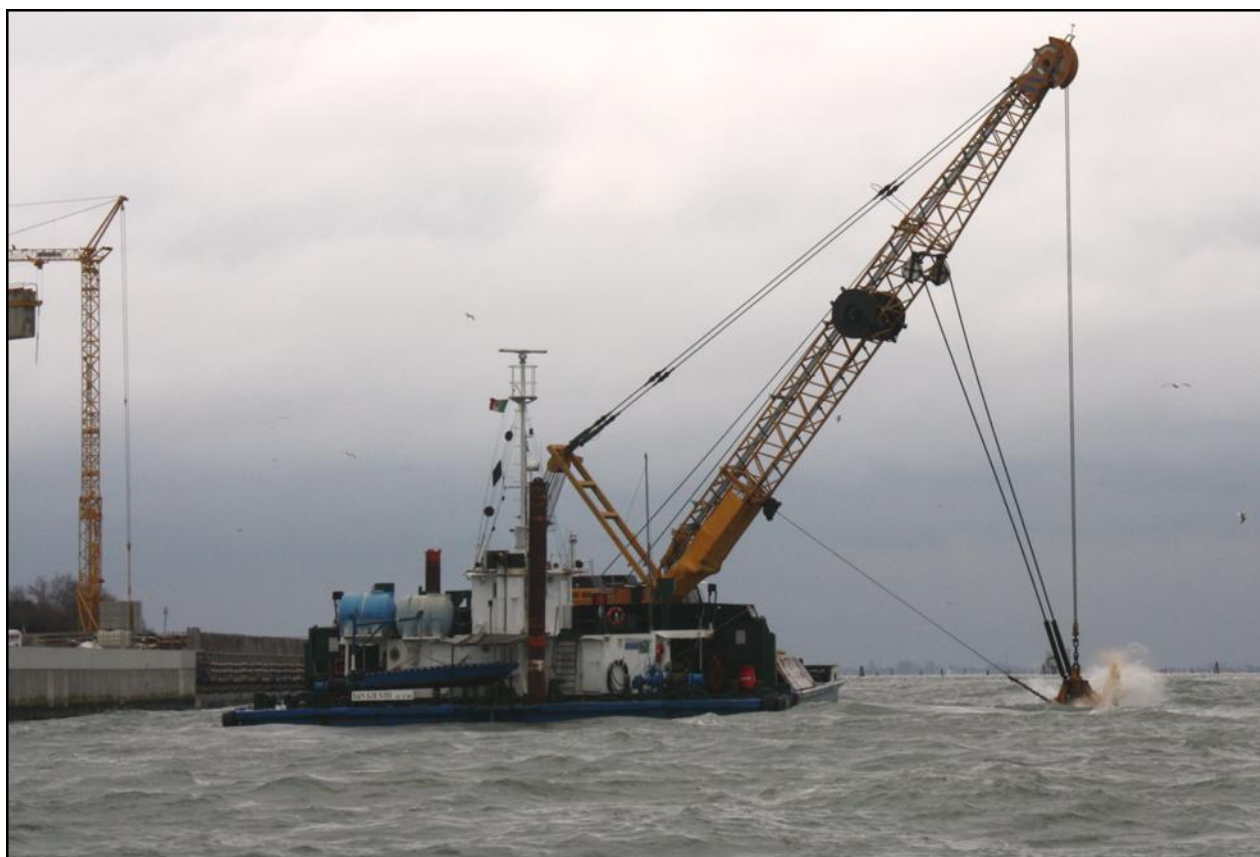
Figura 4.4. Imbarcazione San Giusto, munita di benna a grappo, mentre scarica pietrame il giorno 8 Marzo 2016, bocca di porto di Chioggia.
