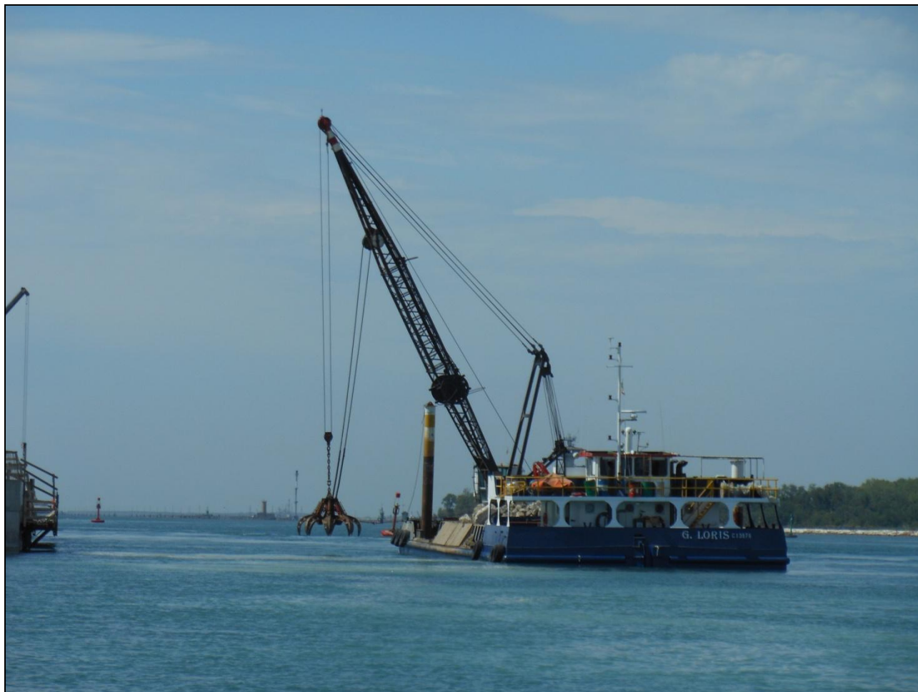
Figura 30. Imbarcazione "G.LORIS" impegnata nel rilascio del materiale lapideo nei pressi della spalla sud. Bocca di Porto di Malamocco.
