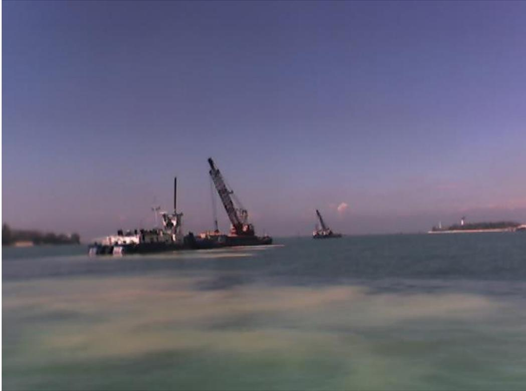
Fig. 2.11. Pontone in primo piano a sinistra nella figura che scarica pietrame a nord del canale navigabile della bocca di porto.
