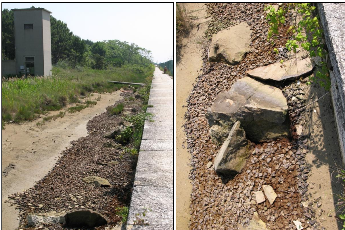
Foto 3.10 - Area delle pozze di sifonamento localizzate oltre la piarda e non oggetto del monitoraggio. Sui massi e sui ciottoli non sono stati trovati talli dell'alga bruna Fucus virsoides .
