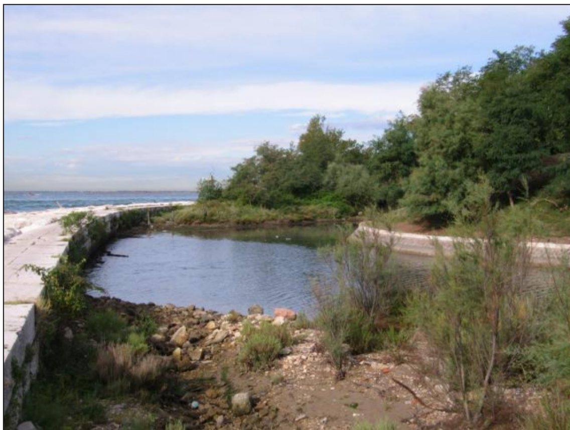
Figura 2.2 – Settembre 2010 . In alto: immagini dell'area di campionamento presso le pozze di sifonamento. In basso: immagine dell'area di campionamento presso il fossato dell'ex-Forte.
