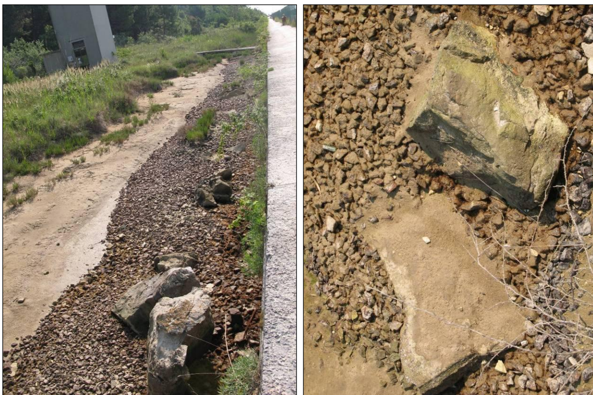
Foto 3.20 – Area delle pozze di sifonamento localizzate oltre la piarda e non oggetto del monitoraggio. Sui massi e sui ciottoli non sono stati trovati talli dell'alga bruna Fucus virsoides .
