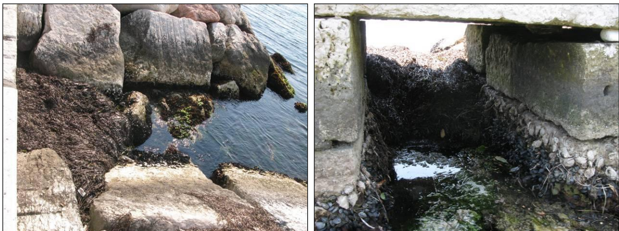
Foto 3.4 - Stazione 1 : a sinistra, ammasso di lamine fogliari morte di Zostera marina , localizzate in corrispondenza dell'apertura della chiusa e concentrate in ingresso nel fossato. A destra, l'ammasso di ciuffi fogliari visto dal lato interno della diga, in corrispondenza del fossato.
