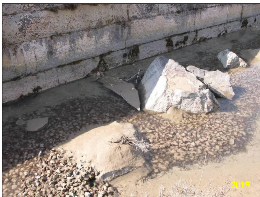
Foto 6.9 - Molo foraneo nord (nella zona oltre le aree monitorate e oltre la piarda): in questa zona i sopralluoghi a marzo 2013 (in alto a sinistra), a marzo 2014 (in alto a destra) e a marzo 2015 (al centro e in basso) hanno evidenziato una quantità elevata di sedimento fangoso (meno abbondante nel 2015).
