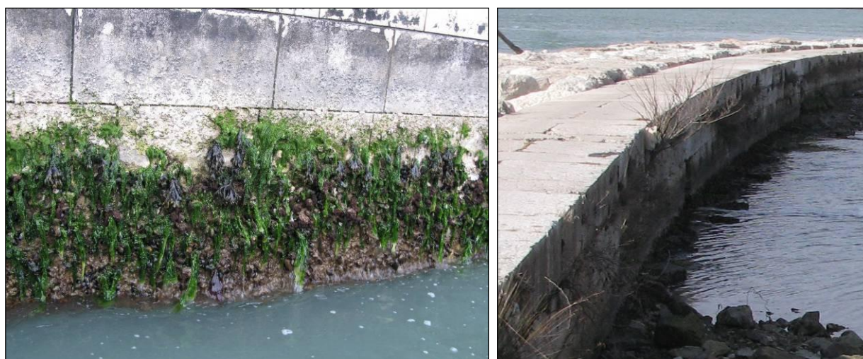
Figura 3.7 - A sinistra, macroalghe presenti lungo il Forte di S. Andrea: oltre a Fucus sono ben visibili le alghe verdi appartenenti al genere Ulva . A destra, pareti interne della diga (lato fossato).
