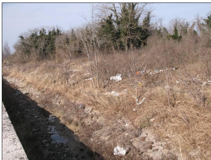
Figura 3.3b - Immagini delle pozze di sifonamento, dove sono localizzate le stazioni 2 e 3, durante il sopralluogo di marzo 2015.
