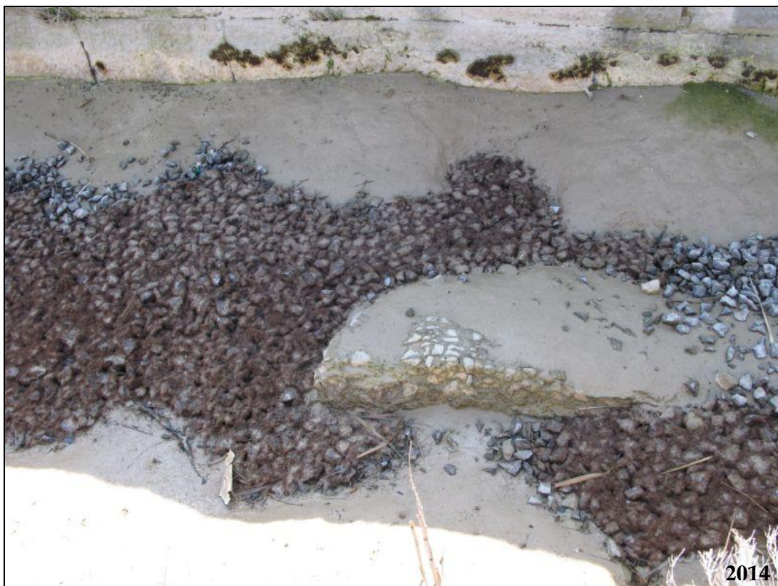
Foto 6.9 - Molo foraneo nord (nella zona oltre le aree monitorate e oltre la piarda): in questa zona i sopralluoghi a marzo 2013 (in alto) e a marzo 2014 (in basso) hanno evidenziato una quantità elevata di sedimento fangoso.
