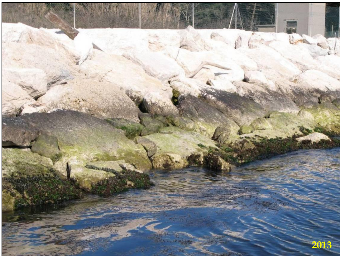
Foto 6.11 - Molo foraneo nord (nella zona oltre le aree monitorate e oltre la piarda), a marzo 2011 (foto in alto) e a marzo 2013 (foto in basso); in questa zona i sopralluoghi non hanno rilevato la presenza di Fucus virsoides .
