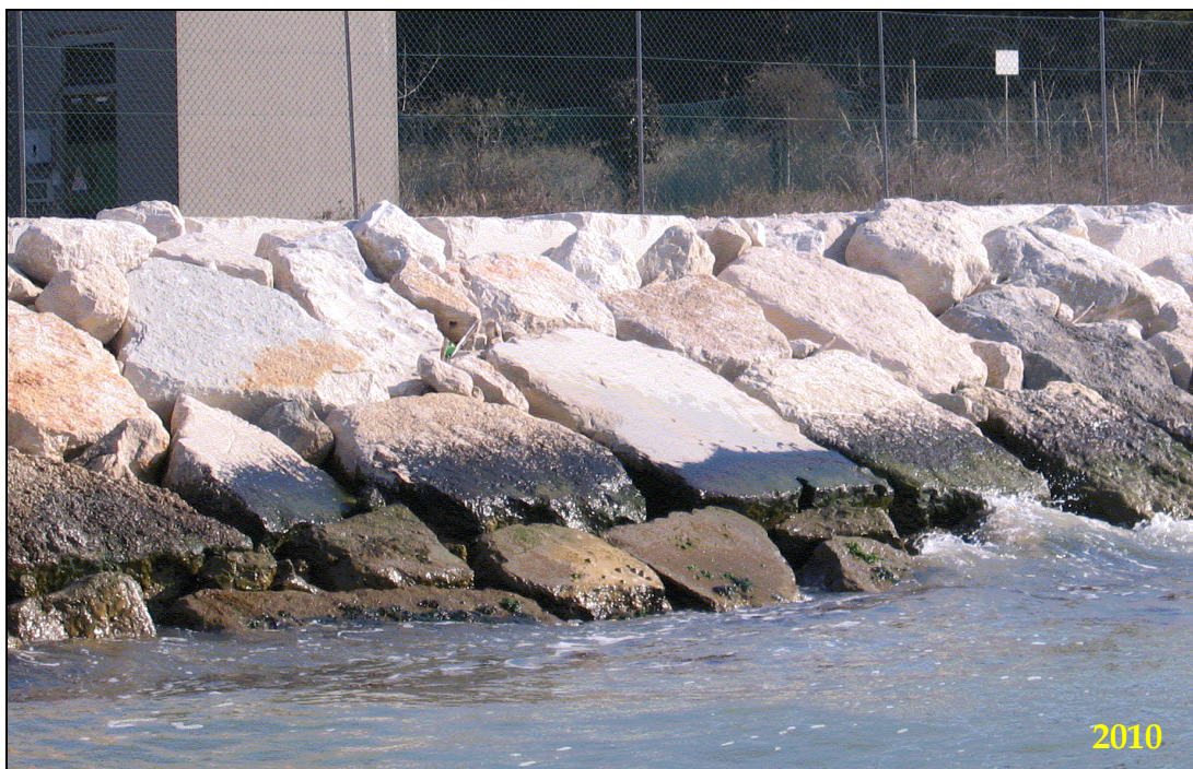
Foto 6.10 - Molo foraneo nord (nella zona oltre le aree monitorate e oltre la piarda), a marzo 2009 (foto in alto) e a marzo 2010 (foto in basso); in questa zona i sopralluoghi non hanno rilevato la presenza di Fucus virsoides .
