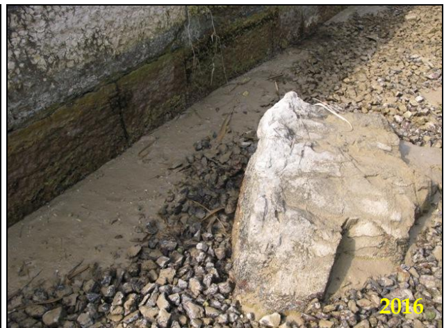
Foto 6.9 – Molo foraneo nord (nella zona oltre le aree monitorate e oltre la piarda): in questa zona i sopralluoghi effettuati tra marzo 2013 e marzo 2016 hanno evidenziato una quantità elevata di sedimento fangoso (meno abbondante nel 2015 e nel 2016).
