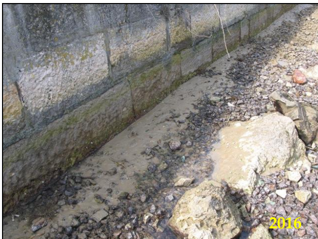
Foto 6.9 – Molo foraneo nord (nella zona oltre le aree monitorate e oltre la piarda): in questa zona i sopralluoghi effettuati tra marzo 2013 e marzo 2016 hanno evidenziato una quantità elevata di sedimento fangoso (meno abbondante nel 2015 e nel 2016).
