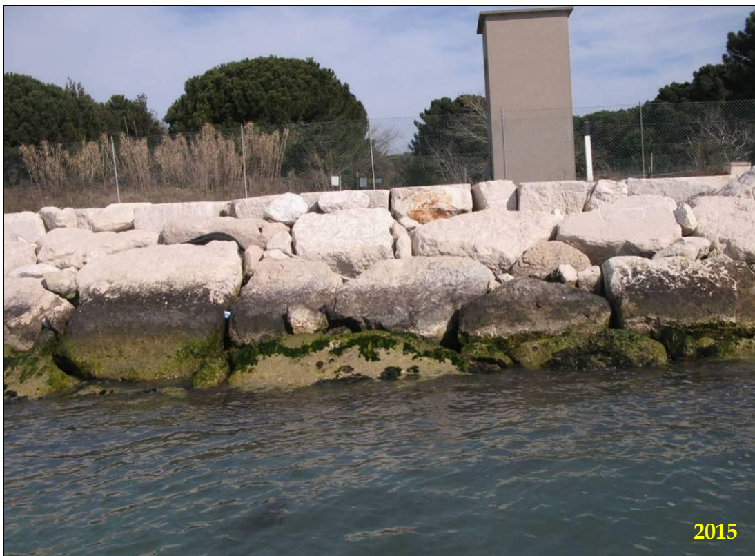
Foto 6.12 – Molo foraneo nord (nella zona oltre le aree monitorate e oltre la piarda), a marzo 2014 (foto in alto) e a marzo 2015 (foto in basso); in questa zona i sopralluoghi non hanno rilevato la presenza dell'alga bruna Fucus virsoides .
