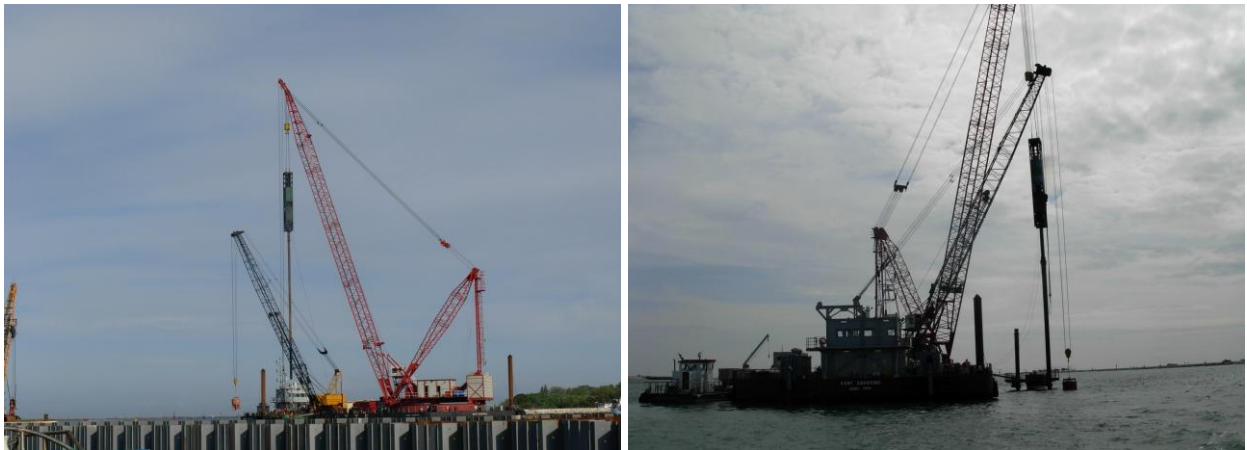
Figura 3: Foto del pontone con il battipalo (scattate il 17 e 24 aprile 2009)
