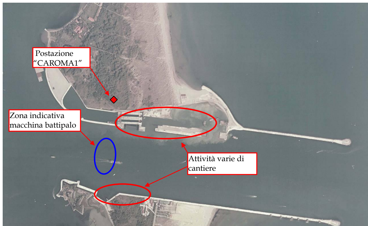
Figura 1: Individuazione della postazione di misura CAROMA1, della macchina battipalo e delle zone in cui è presente attività di cantiere
