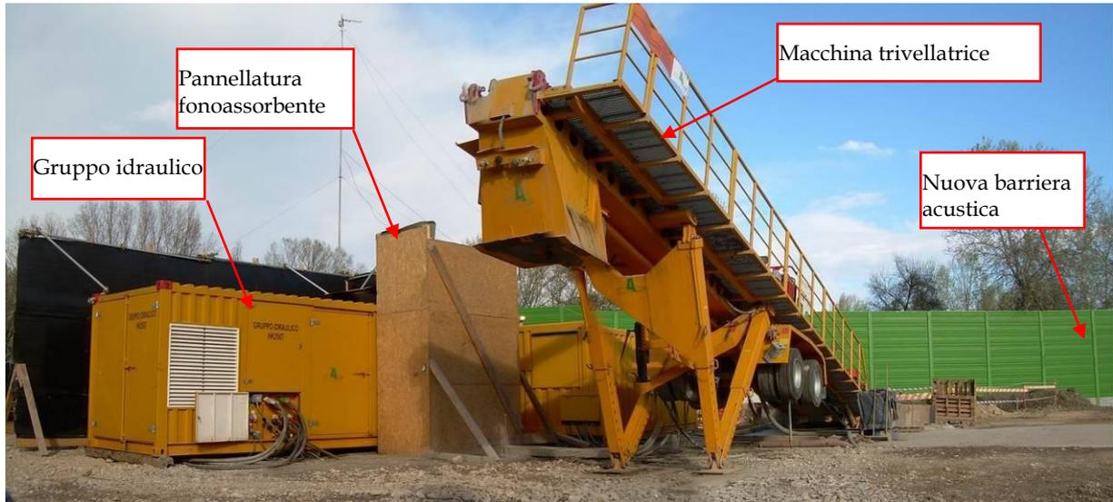
Figura 60: Foto della zona di cantiere del cavidotto. Si possono notare la macchina per la trivellazione orizzontale (al centro), il gruppo idraulico schermato da una prima pannellatura fonoassorbente (sulla sinistra) ed una seconda barriera acustica (in verde sullo sfondo). Foto scattata in data 03 Aprile 2008.
