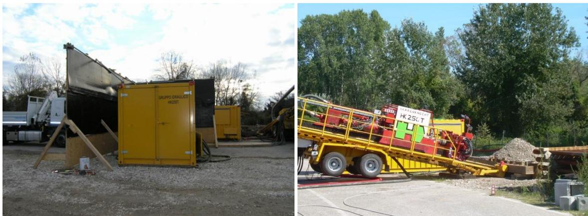
Figura 20: Individuazione del gruppo idraulico con annessa pannellatura fonoassorbente (a sinistra) e macchina per la trivellazione orizzontale teleguidata (a destra). Le foto sono state scattate nel primo periodo di monitoraggio, prima dell'installazione della nuova pannellatura fonoassorbente.
