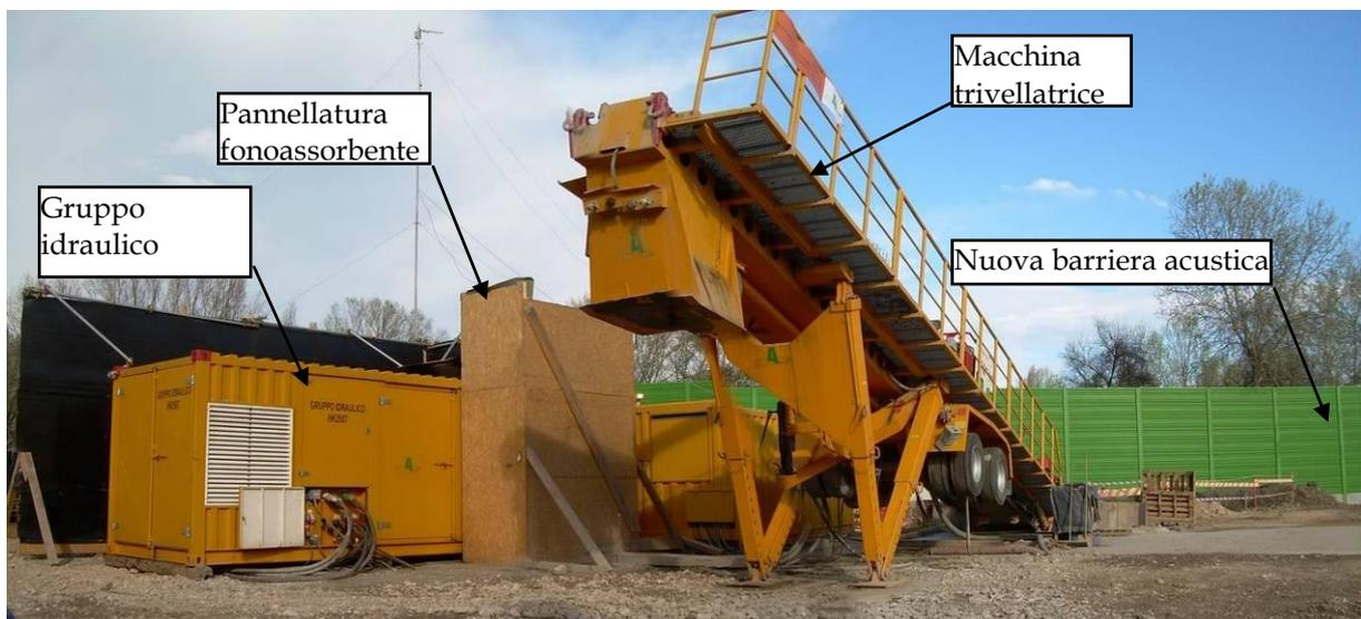
Figura 22: Foto della zona di cantiere del cavidotto. Si possono notare la macchina per la trivellazione orizzontale (al centro), il gruppo idraulico schermato dalla pannellatura fonoassorbente (sulla sinistra) e la nuova barriera acustica (in verde sullo sfondo). Foto scattata in data 03-04-2008.
