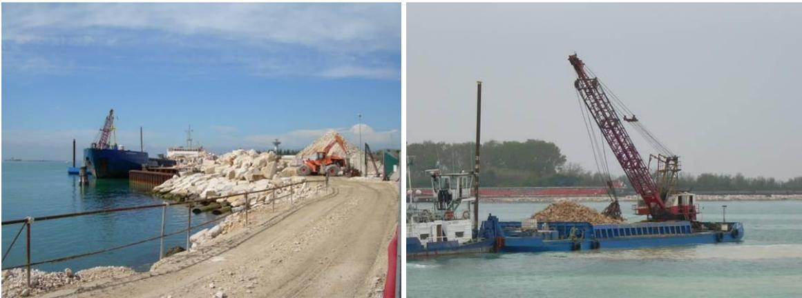
Figura 30: Foto dell'attività di stoccaggio di pietrisco sulla piarda (a sinistra) e attività di una piattaforma a ragno nel mezzo della Bocca di Malamocco (a destra).
