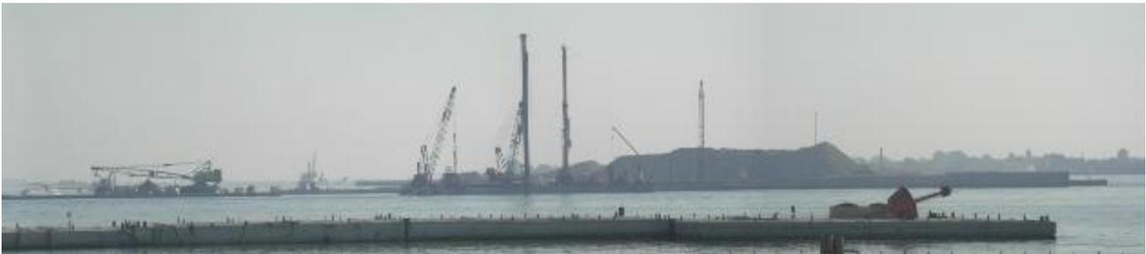
Figura 17: Foto della zona di cantiere nella bocca di Lido. Al centro si possono notare le due macchine battipalo. Foto scattata in data 19 giugno 2009
