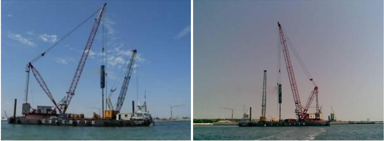
Figura 4: Foto del pontone con il battipalo (scattate rispettivamente il 19 giugno e il 14 luglio 2009)
