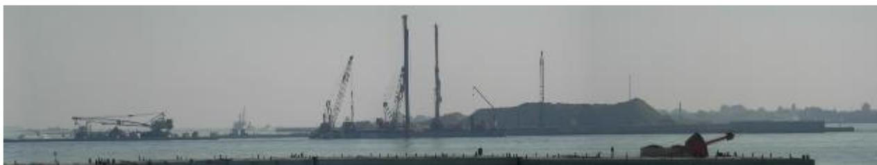
Figura 4: Foto della zona di cantiere nella bocca di Lido. Al centro si può notare la macchina battipalo con i due lati di battitura. Foto scattata in data 19 giugno 2009
