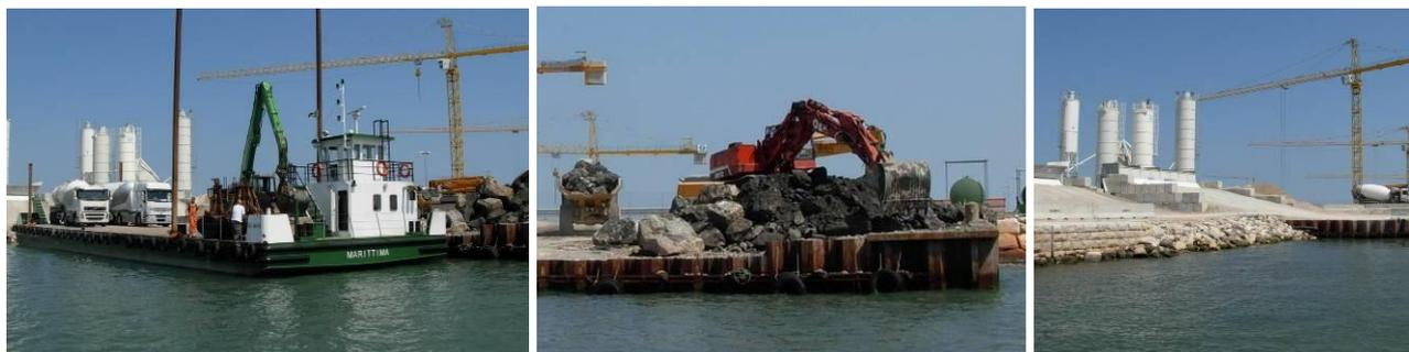
Figura 71: insieme di "lavorazioni spalla Nord", chiatta per il trasporto di automezzi (sinistra), attività con escavatore e camion nei pressi del molo di attracco (centro), passaggio betoniere nei pressi dell'impianto di betonaggio (destra)
