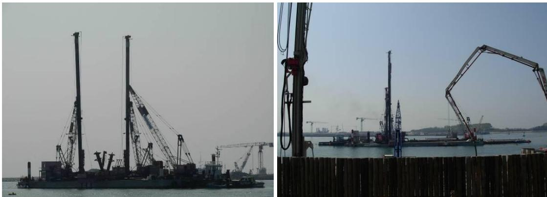
Figura 86: Foto del pontone con i dispositivi battipalo, scattate dalla spalla Nord il 14 e 20 Aprile 2010
