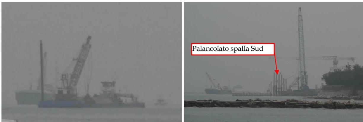
Figura 35: Foto dell'attività della piattaforma a ragno (a sinistra) e della zona di infissione delle palancole sulla spalla Sud (a destra). Foto scattate il 24 Novembre 2009
