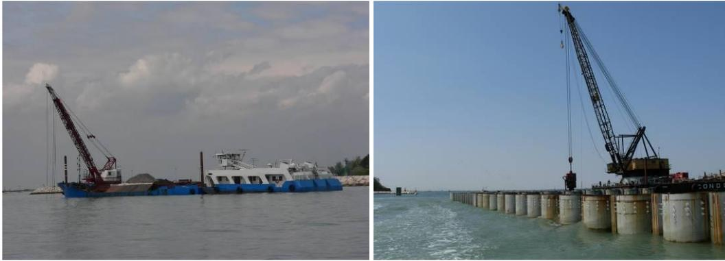
Figura 72: foto della motonave per il dragaggio del fondale (sinistra) e della gru per l'infissione palancole (destra)
