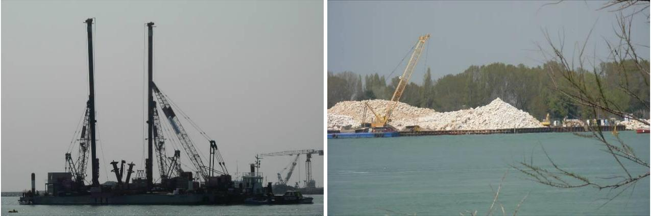
Figura 45: Foto della macchina battipalo (a sinistra) e dell'attività di carico pietrame sulla piarda di Alberoni (a destra). Foto scattate il 14 Aprile 2010
