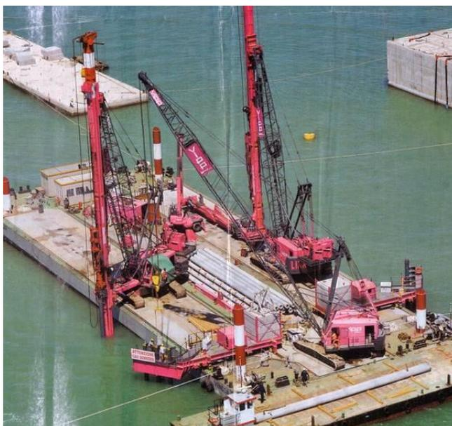
Figura 84: Foto del pontone con i due dispositivi battipalo
