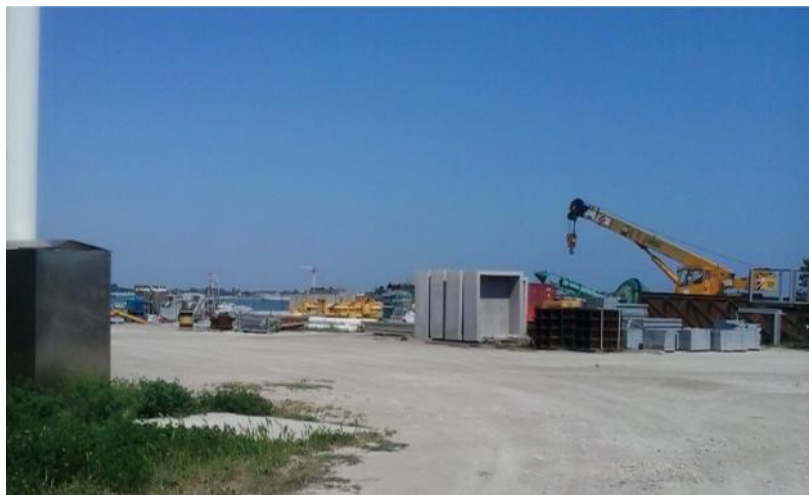
Figura 30: Foto cantiere di spalla Sud (foto scattata il 25 Maggio 2015).
