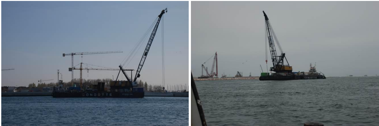
Figura 4: Foto di un motopontone in lavorazione fra la spalla nord e la spalla sud. Immagini scattate il 13 Aprile 2015 (destra) e il 4 Maggio 2015 (sinistra).
