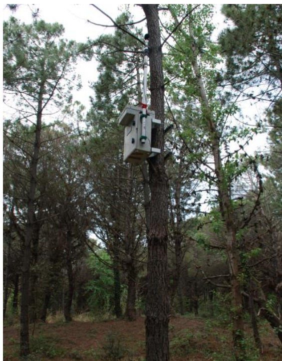
Figura 17: Centralina di monitoraggio
