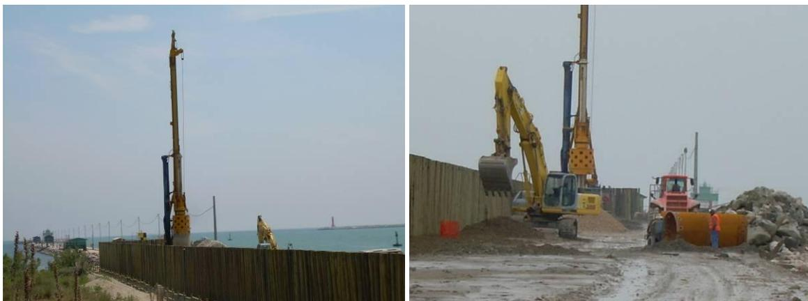
Figura 31: Attività di una macchina escavatrice e di una perforatrice sulla spalla nord (a destra).
