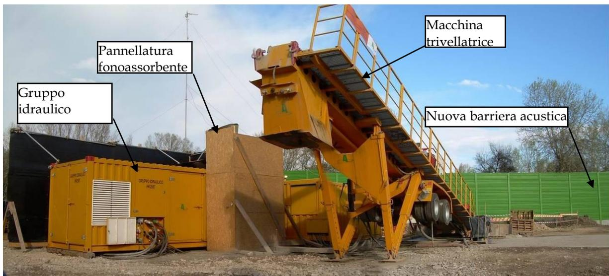
Figura 22: Foto della zona di cantiere del caviodotto. Si possono notare la macchina per la trivellazione orizzontale (al centro), il gruppo idraulico schermato dalla pannellatura fonoassorbente (sulla sinistra) e la nuova barriera acustica (in verde sullo sfondo). Foto scattata in data 03-04-2008.
