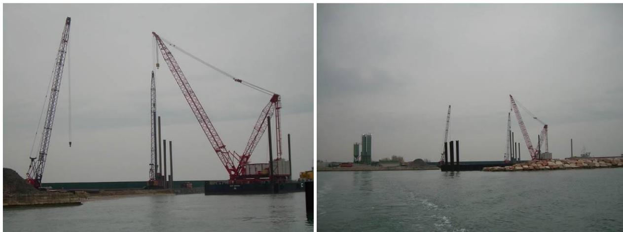
Figura 42: Foto della zona di infissione delle palancole. Foto scattate in data 16-1-2008.
