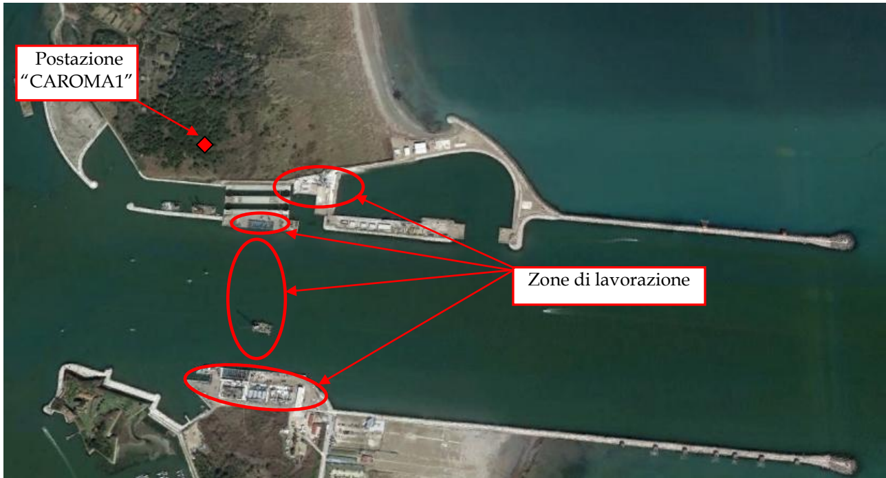
Figura 2. Individuazione della postazione di misura CAROMA1 e delle zone di lavorazione.
