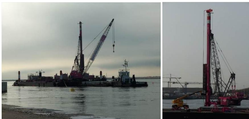
Figura 37: a sinistra, foto del motopontone impiegato per la battitura pali; a destra particolare della macchina battipalo (scattate il 3 Ottobre).
