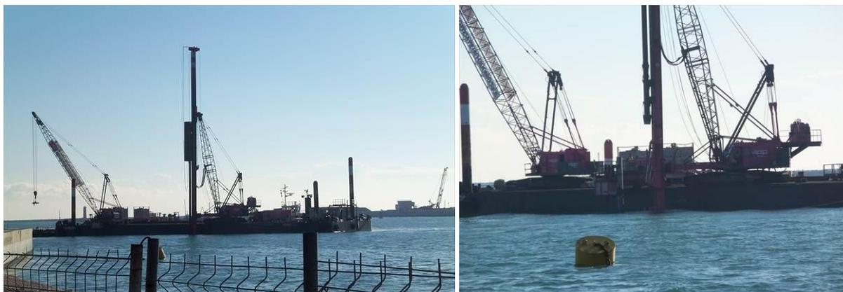
Figura 17: Foto del motopontone impiegato per la battitura posizionato a circa 80 m dal recesso di spalla Nord a sinistra, particolare della macchina battipalo a destra (immagini scattate il 6 Dicembre).
