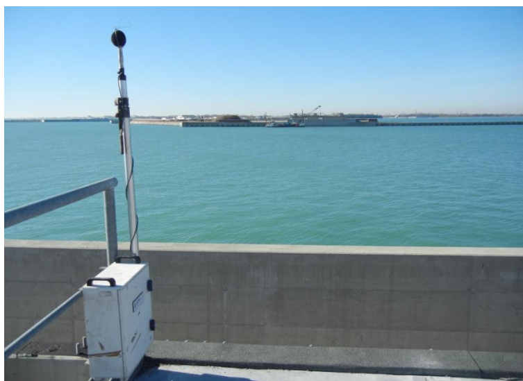
Figura 10. Postazione per la misura del rumore aereo nel cantiere di Lido-Treporti.
