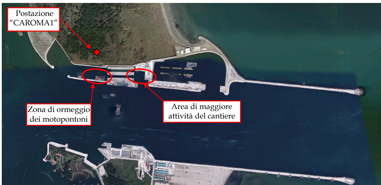
Figura 1. Individuazione della postazione di misura CAROMA1, della zona di ormeggio dei motopontoni nel porto rifugio e dell'area di maggiore attività del cantiere nel periodo concomitante i rilievi.
