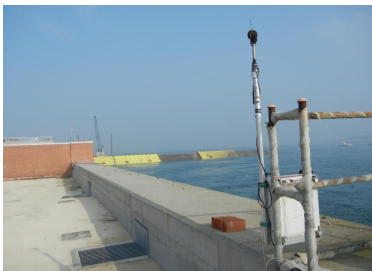
Figura 11. Postazione per la misura del rumore aereo sull'Isola Nuovissima, con le paratoie sollevate.
