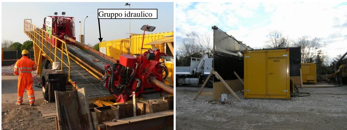
Figura 11. Foto della zona di cantiere del cavidotto con individuazione della macchina per la trivellazione orizzontale teleguidata (a sinistra) e della pannellatura fonoassorbente installata sul gruppo idraulico (a destra). Foto scattate nel mese di novembre.
