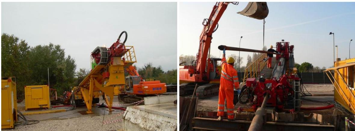
Figura 9. Foto della zona di cantiere del cavidotto con individuazione della macchina per la trivellazione orizzontale teleguidata e della macchina escavatrice. Foto scattate nel mese di ottobre
