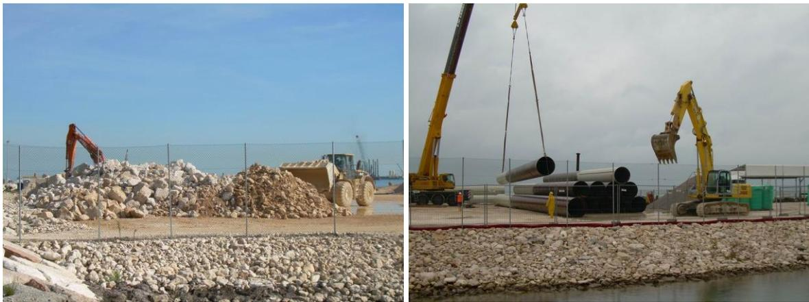
Figura 8. Foto delle attività sulla piarda di Alberoni, a sinistra il carico/scarico del pietrisco, a destra lo stoccaggio di palancole metalliche. Foto scattate nel mese di ottobre
