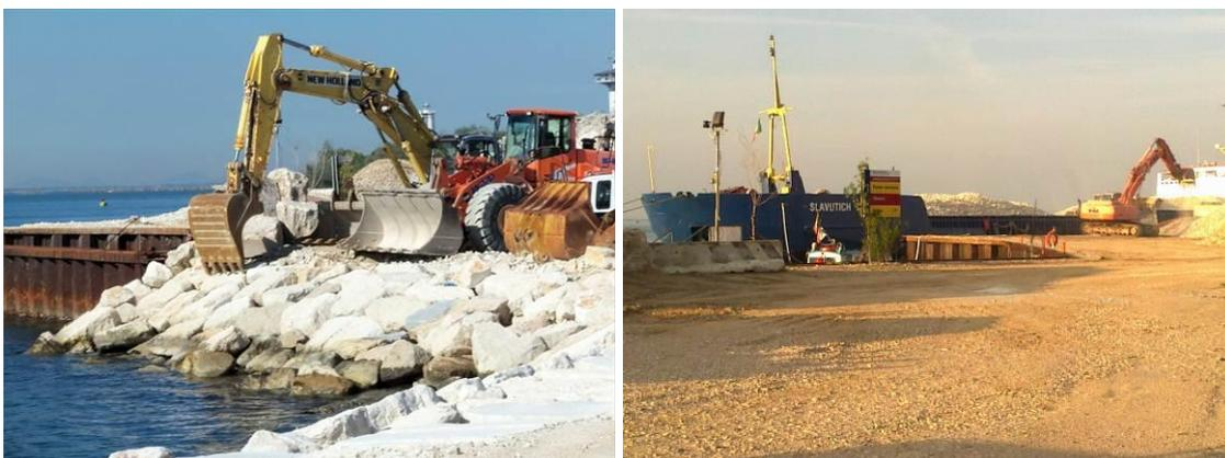
Figura 13: a sinistra, foto di un escavatore sulla piarda di Alberoni (scattata il 21 Settembre); a destra, foto di una motonave attraccata alla piarda durante le operazioni di scarico pietrame (scattata il 18 Ottobre).
