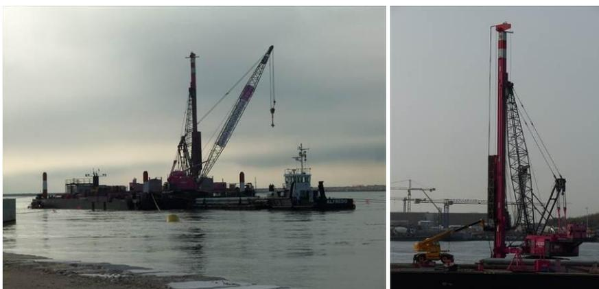
Figura 24: a sinistra, foto del motopontone impiegato per la battitura pali; a destra particolare della macchina battipalo (scattate il 3 Ottobre).
