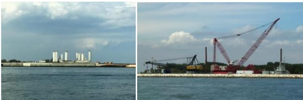
Figura 40: Foto dell'impianto di betonaggio (a sinistra) - scattata il 10 Maggio 2013 all'interno della bocca; foto di due motopontoni posizionati nella zona di ormeggio (a destra)- scattata il 22 Maggio 2013.
