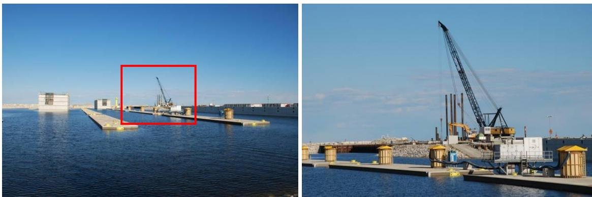
Figura 43: Foto del bacino di prefabbricazione (a sinistra) con evidenziata e ingrandita (a destra) l'area di rimozione delle palancole. Immagini scattate il 16 Aprile 2014.
