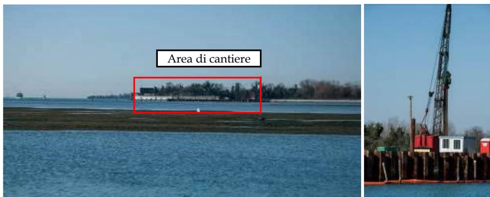
Figura 14: Foto dell'area del cantiere vista dall'Isola di Sant'Erasmus (a sinistra) e foto del vibroinfissore in azione agganciato ad una palancole (a destra). Immagini scattate il 24 Febbraio 2014.
