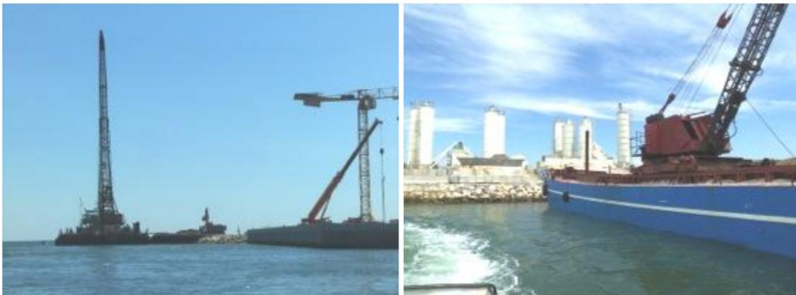
Figura 45:Foto del motopontone mentre attracca sulla spalla Sud (a sinistra) -scattata il 14 Maggio 2013; foto dei motopontoni impiegati per il trasporto di materiale e mezzi di cantiere mentre attraccano sulla spalla Nord (a destra).
