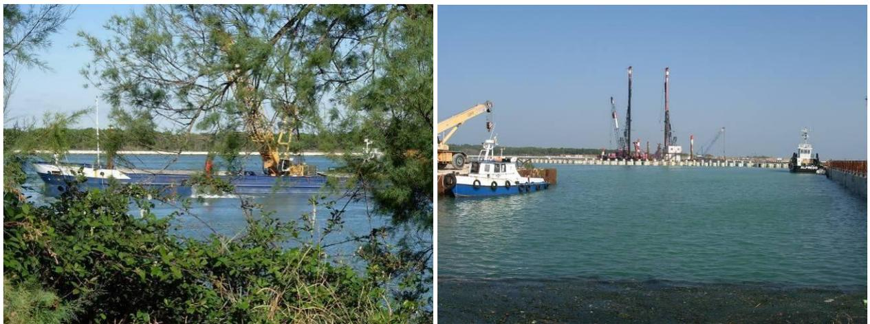
Figura 20: foto della motonave con piattaforma a ragno per il dragaggio del fondale, scattata il 7 Ottobre 2010 dalla terrazza della casa di riposo (sinistra); foto della macchina battipalo vista dal cantiere di Santa Maria del Mare, scattata il 15 Ottobre 2010 (destra).
