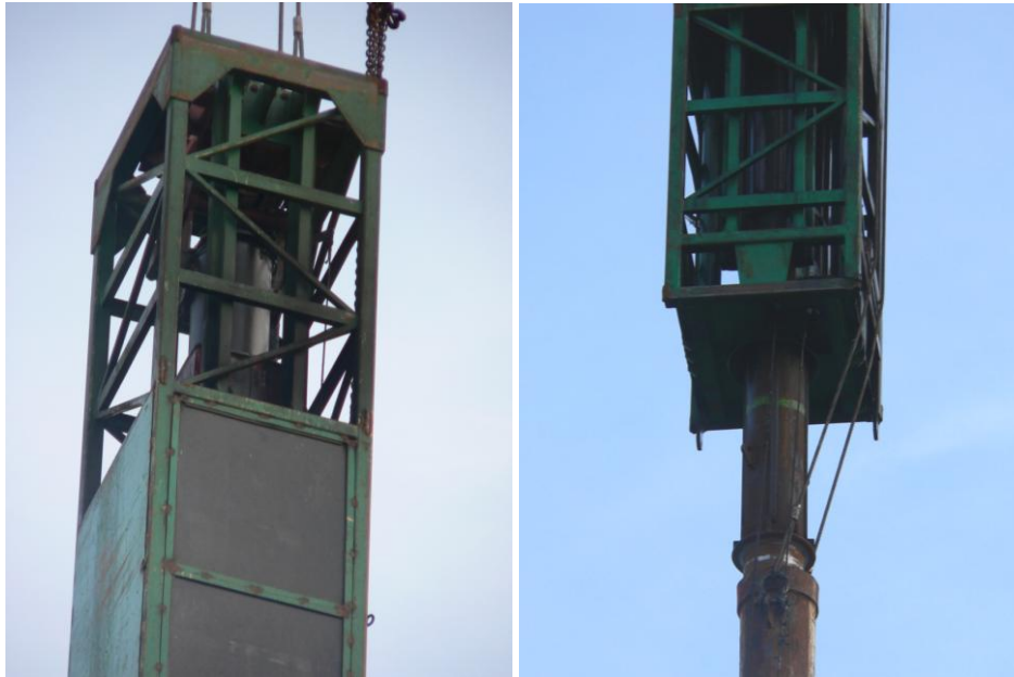
Figura 50: Foto della parte superiore e della parte inferiore del sistema di battitura pali. Foto scattate in data 24 Ottobre2008
