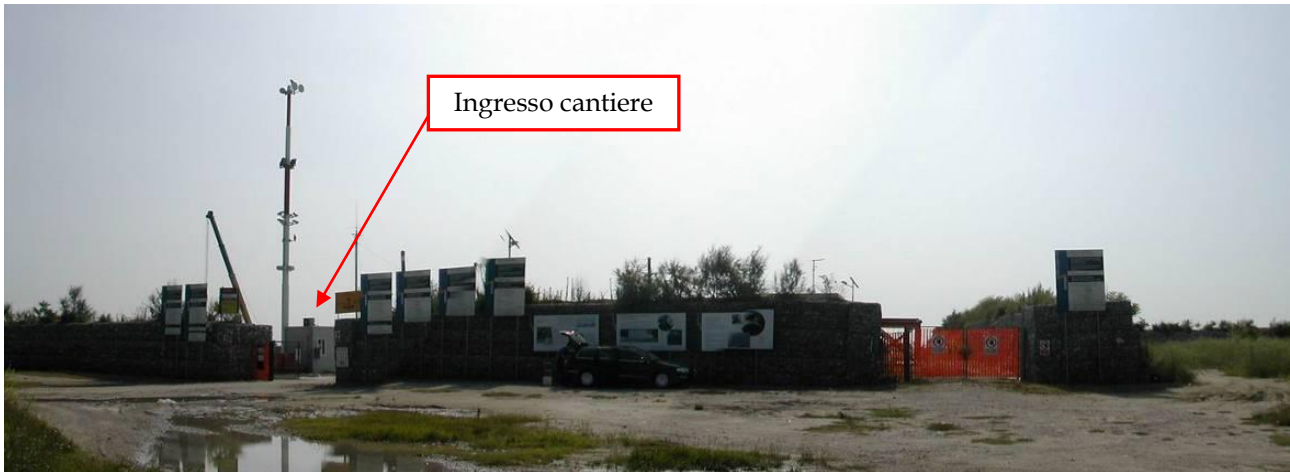
Figura 4: Foto esterna della zona di cantiere della spalla sud con individuazione dell'ingresso . Foto scattata in data 10 luglio 2008
