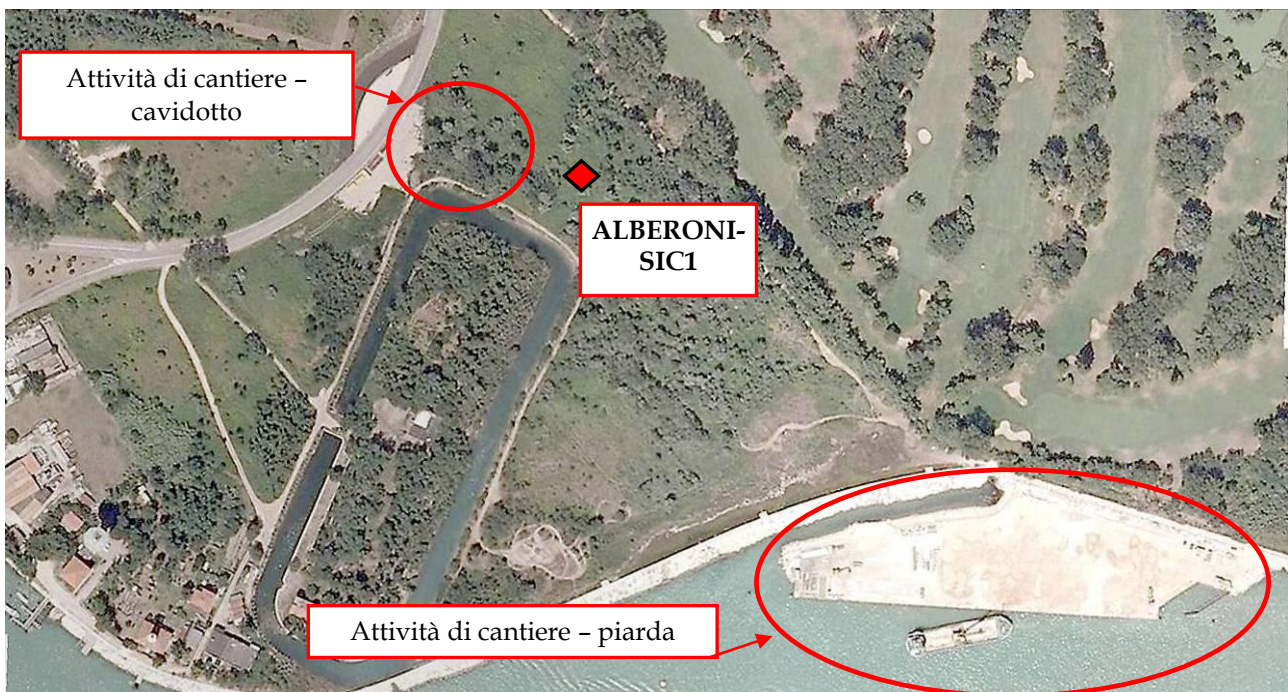
Figura 10: Individuazione postazione di misura ALBERONI-SIC1 e zone in cui è presente attività di cantiere
