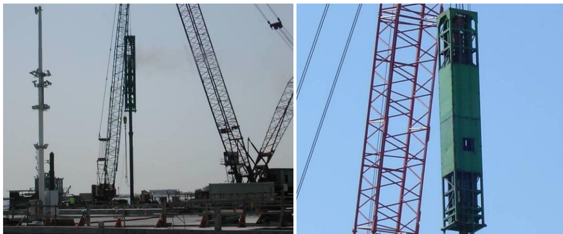
Figura 39: Foto della macchina battipalo priva di schermatura acustica, scattata il 29 agosto 2008 (a sinistra) e della macchina battipalo con schermatura acustica, scattata il 23 settembre 2008 (a destra)
