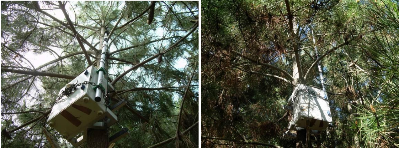
Figura 36: Immagini della centralina di monitoraggio nella postazione "CAROMA1". Foto scattate in data 11/06/08 (sinistra) e in data 17/04/09 (destra)
