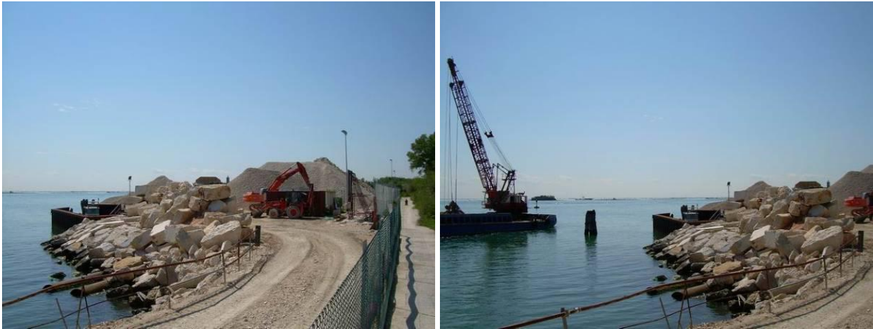
Figura 11: Foto della zona di cantiere sulla piarda. Foto scattate in data 06-05-2008
