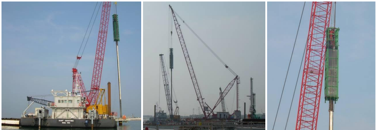
Figura 38: Immagini della macchina per la battitura pali (a sinistra ed in centro) e particolare della chiusura fonoisolante attorno all'area di azione del battipalo (a destra); foto scattate in data 11 Giugno 2008
