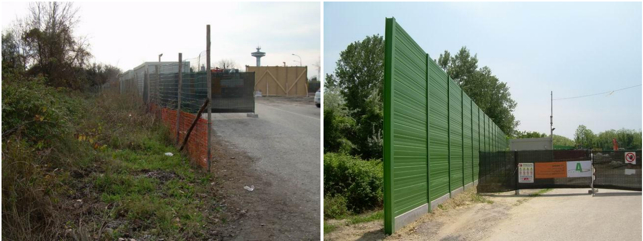
Figura 15: Foto della zona di ingresso al cantiere prima (a sinistra) e dopo (a destra) la realizzazione della barriera
