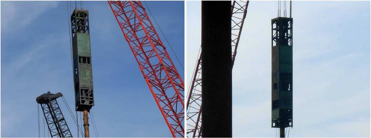
Figura 40: Foto del battipalo da due lati opposti con schermatura modificata. Foto scattate in data 17 Aprile 2009 (a sinistra) e 24 aprile 2009 (a destra)
