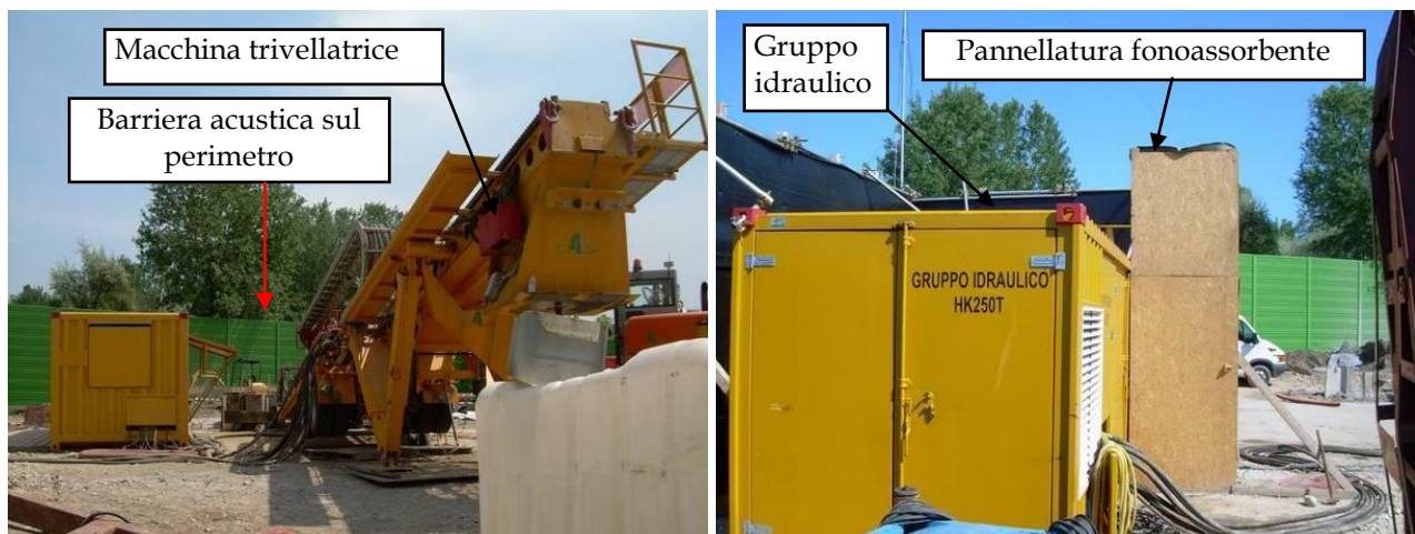
Figura 12: Foto della zona di cantiere del cavidotto. A sinistra si può notare la macchina per la trivellazione orizzontale e la barriera acustica installata sul perimetro del cantiere (foto scattata in data 15 maggio 2008). A destra si può notare il gruppo idraulico schermato dalla pannellatura fonoassorbente (foto scattata in data 06-05-2008)
