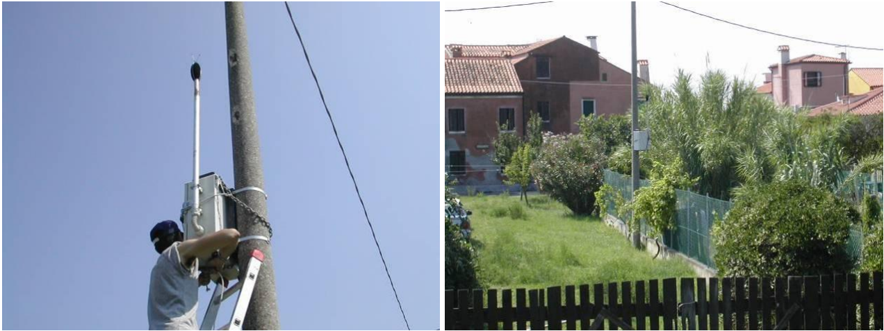
Figura 32: Foto della centralina di monitoraggio. Fasi del montaggio (a sinistra) e vista dal terrapieno a fianco della strada Comunale dei Murazzi (a destra). Foto scattate in data 10 Luglio 2008
