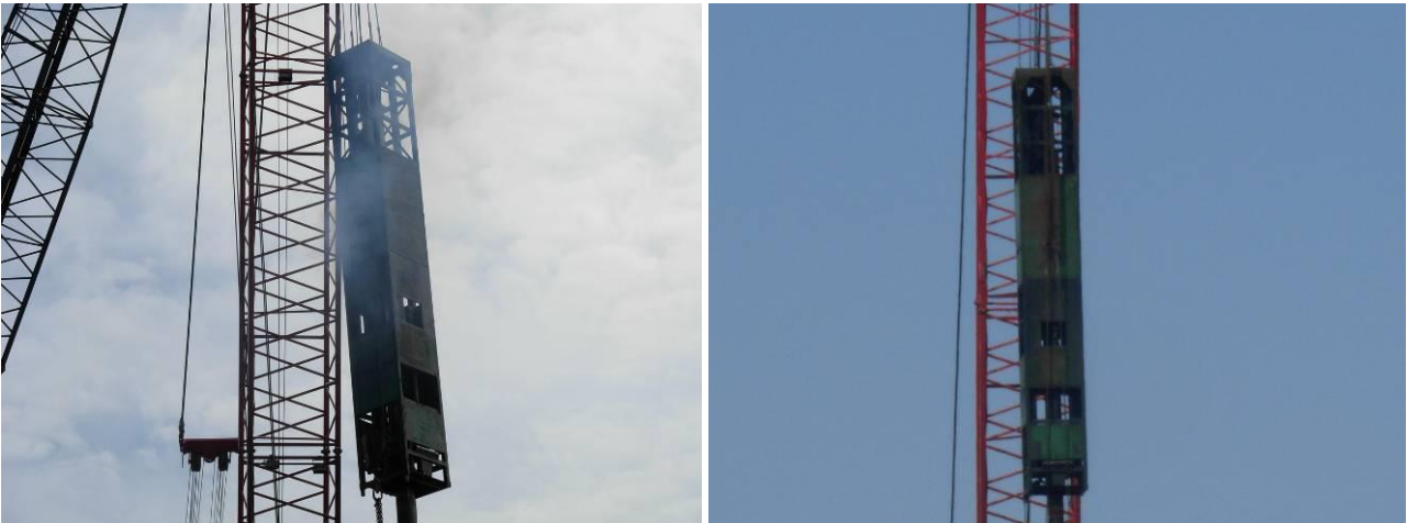
Figura 41: Foto del battipalo da due lati opposti con schermatura modificata. Foto scattate in data 17 Aprile 2009 (a sinistra) e 24 aprile 2009 (a destra)
