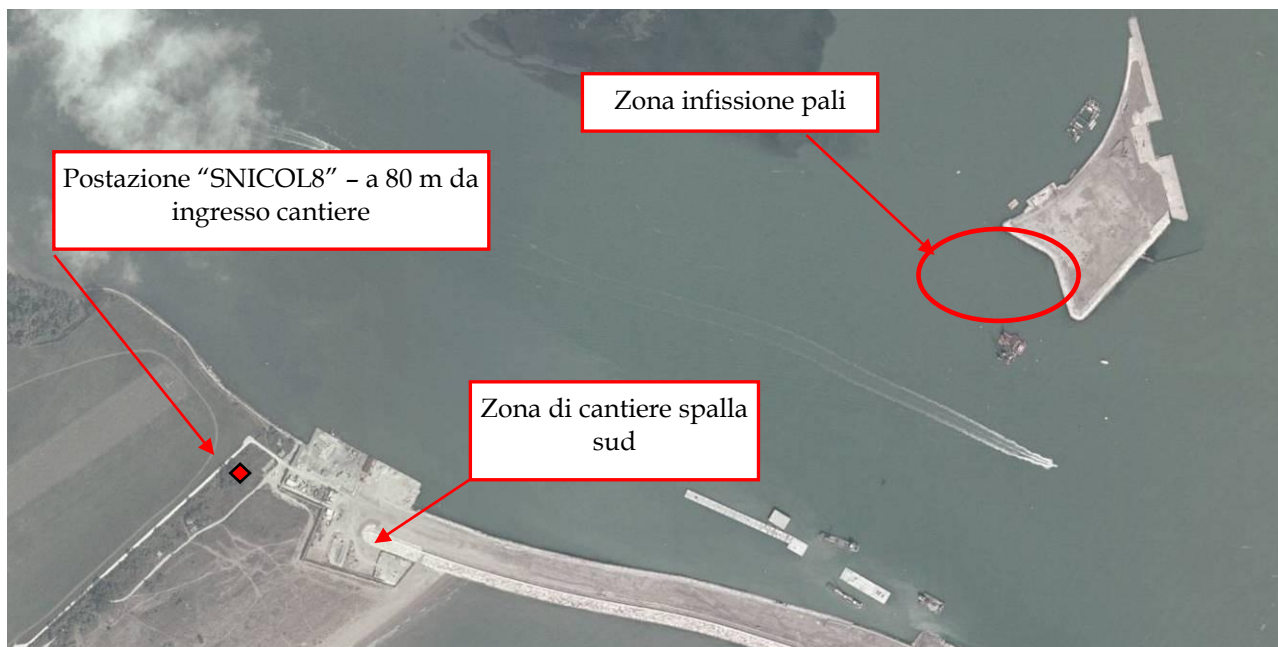
Figura 1: Foto aerea della Bocca di Lido con individuazione della postazione di misura "SNICOL8", dell'area di infissione pali e della zona di cantiere nella spalla sud
