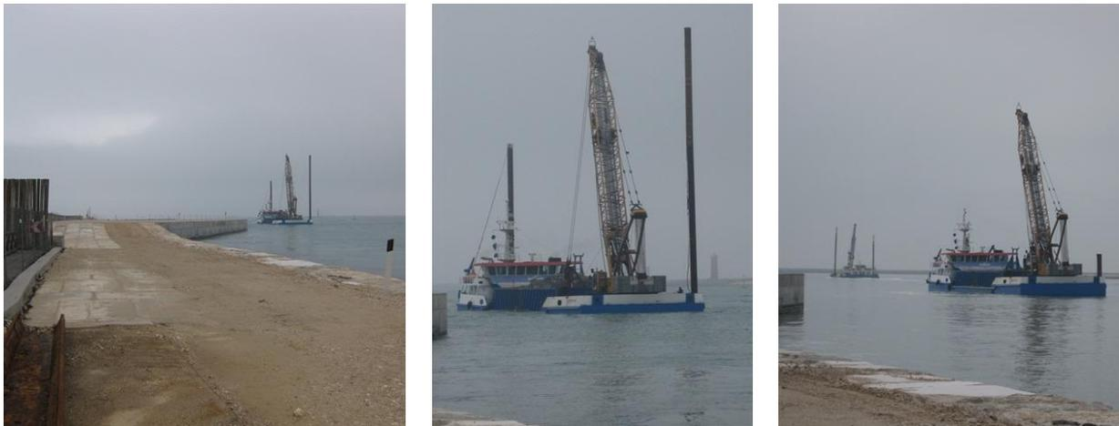
Figura 4: Foto del cantiere della spalla Nord (sinistra) e particolare dell'attività di dragaggio tramite motopontone (al centro, scattata il 04 Aprile, e a destra, scattata il 12 Aprile).
