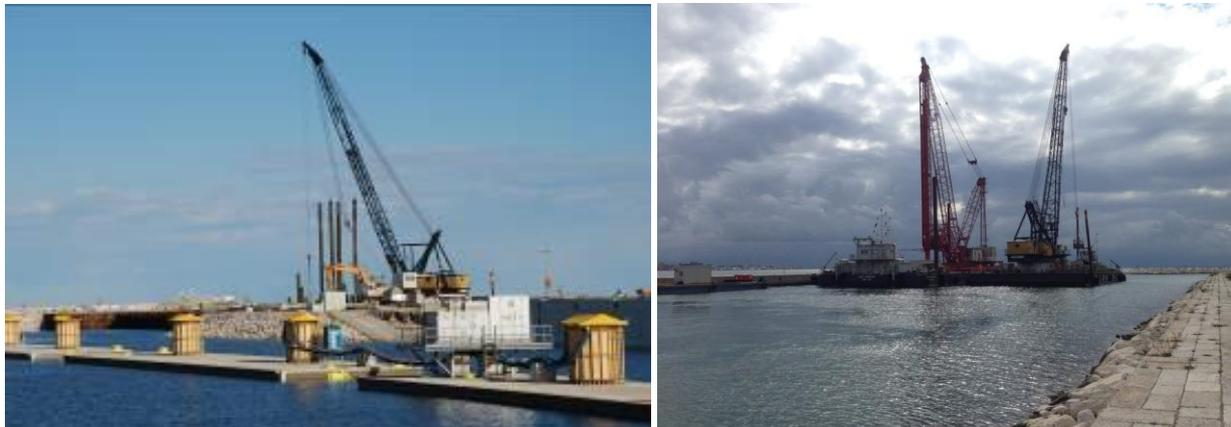
Figura 4: Foto dell'area di rimozione delle palancole nel bacino di prefabbricazione (a sinistra) e foto di motopontoni in manovra all'interno del porto rifugio (destra).
