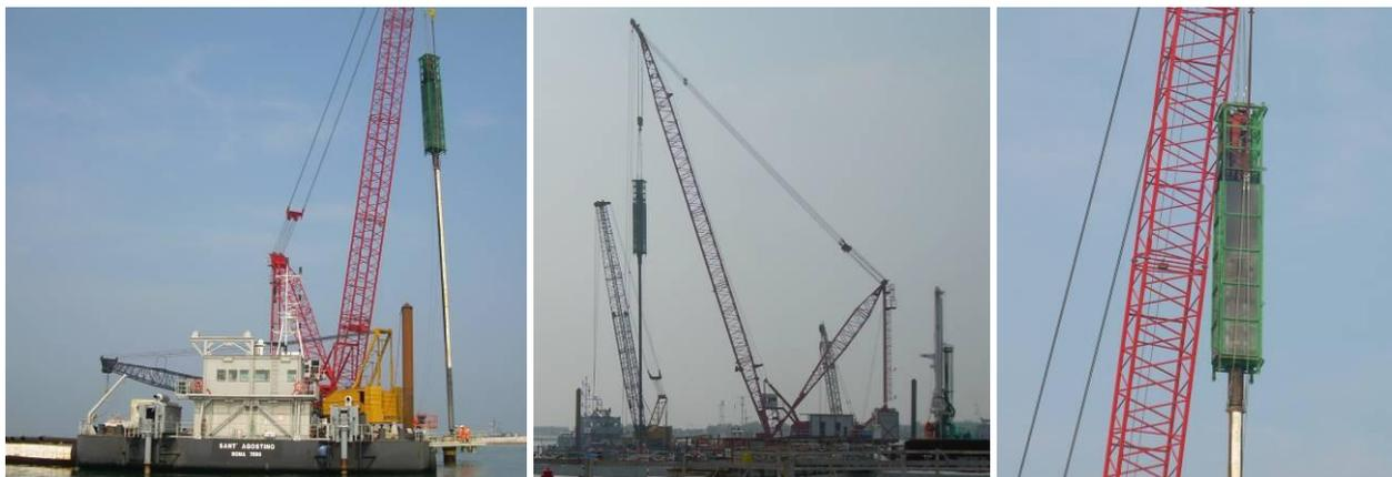
Figura 36: Immagini della macchina per la battitura pali (a sinistra ed in centro) e particolare della chiusura fonoisolante attorno all'area di azione del battipalo (a destra); foto scattate in data 11 Giugno 2008
