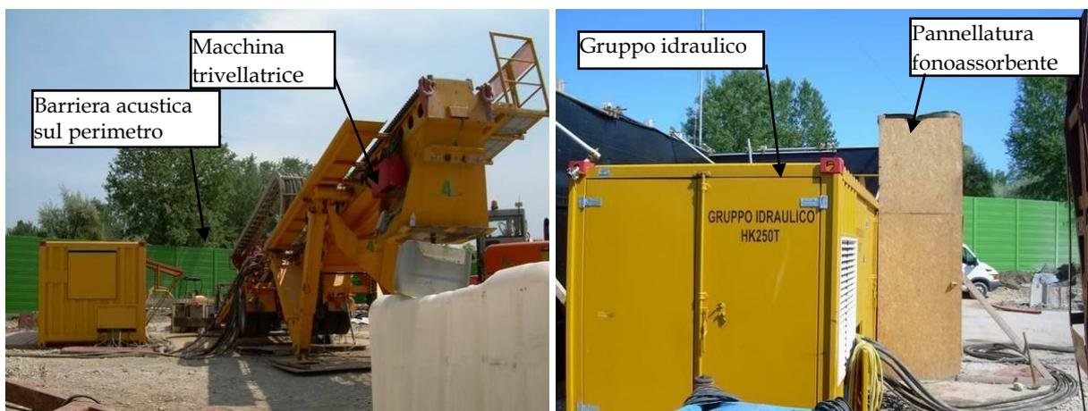
Figura 13: Foto della zona di cantiere del cavidotto. A sinistra si può notare la macchina per la trivellazione orizzontale e la barriera acustica installata sul perimetro del cantiere (foto scattata in data 15 maggio 2008). A destra si può notare il gruppo idraulico schermato dalla pannellatura fonoassorbente (foto scattata in data 06-05-2008)
