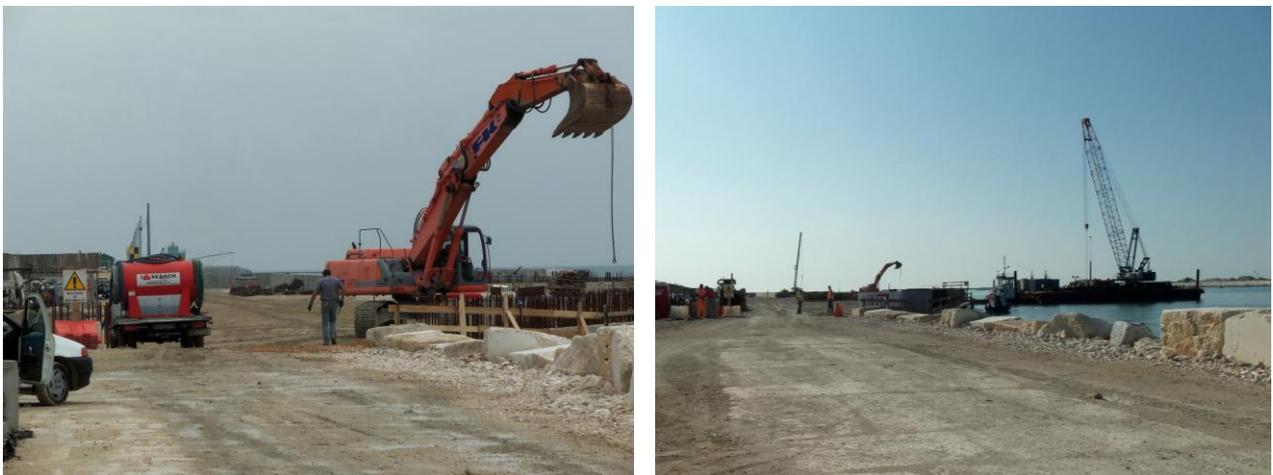
Figura 4: Foto delle attività di cantiere della spalla Nord (sinistra) e del pontone con cui viene effettuata l'attività di vibroinfissione delle palancole, entrambe scattate il 21 Giugno 2011.
