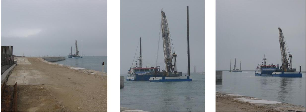
Figura 14: Foto del cantiere della spalla Nord (sinistra) e particolare dell'attività di dragaggio tramite motopontone (al centro, scattata il 04 Aprile, e a destra, scattata il 12 Aprile).
