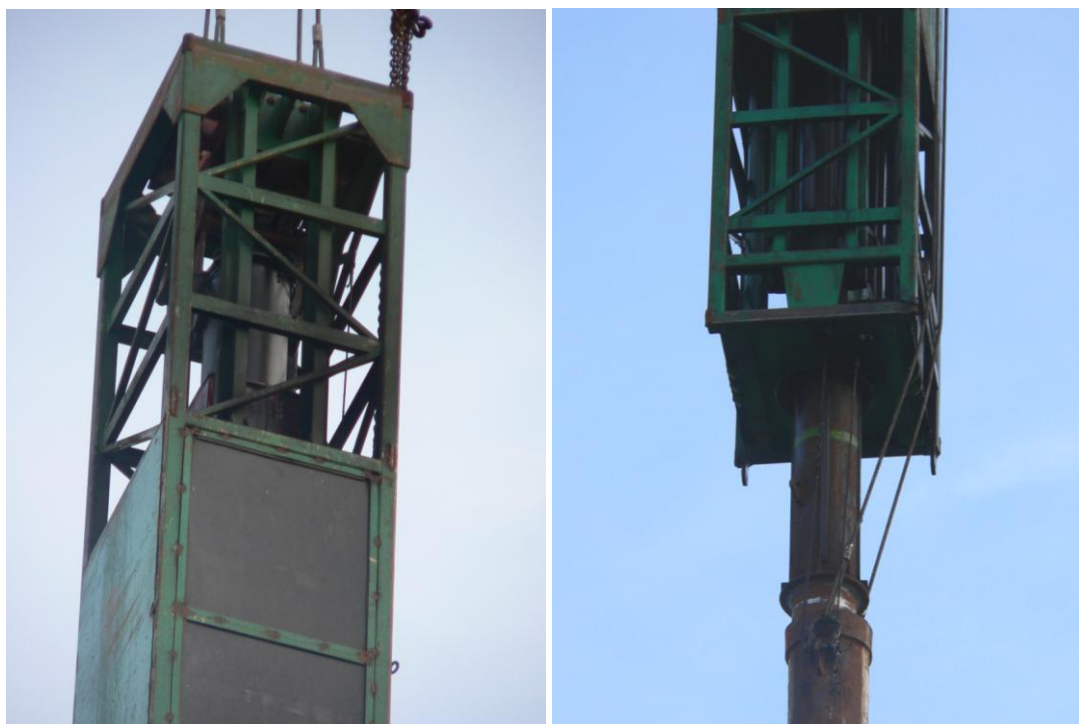
Figura 8: Foto della parte superiore e della parte inferiore del sistema di battitura pali. Foto scattate in data 24 Ottobre 2008
