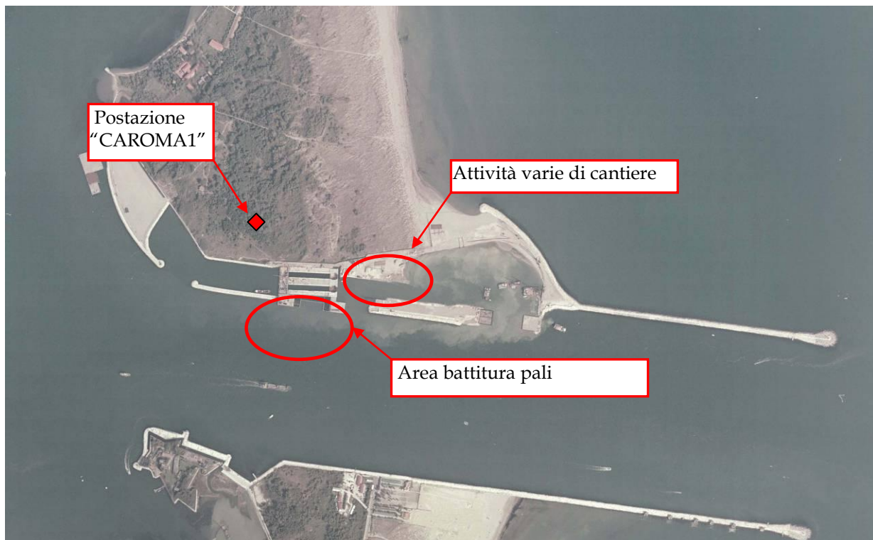
Figura 2: Individuazione della postazione di misura CAROMA1 e delle zone in cui è presente attività di cantiere
