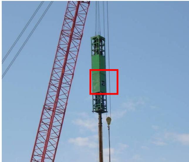
Figura 6: Foto della macchina battipalo con schermatura acustica. Si nota la mancanza dello sportello di chiusura dell'apertura di manutenzione. Foto scattate in data 23 Settembre 2008
