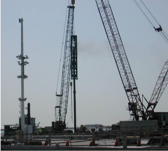
Figura 4: Foto della macchina battipalo priva di schermatura acustica. Foto scattata in data 29 Agosto 2008
