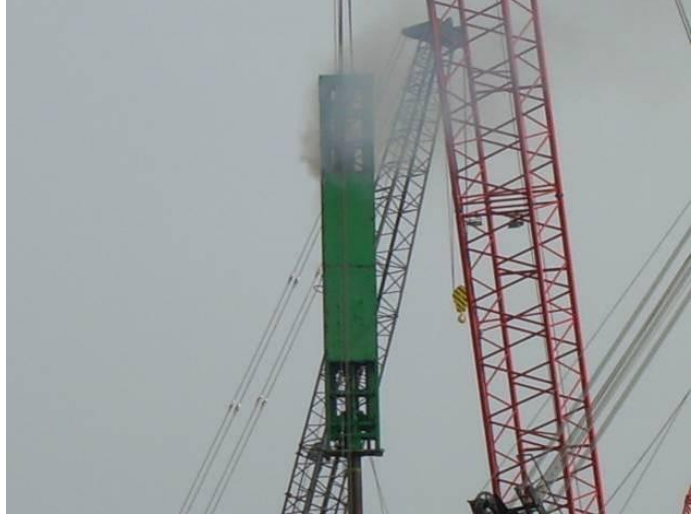
Figura 5: Foto della macchina battipalo con schermatura acustica. Foto scattata in data 11 Settembre 2008
