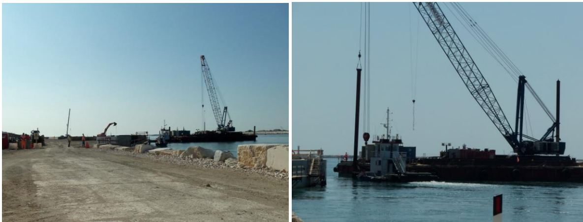
Figura 6: Foto del cantiere della spalla Nord (sinistra), con visualizzazione del pontone (destra) con cui viene effettuata l'attività di vibroinfissione delle palancole, scattate il 21 Giugno 2011.
