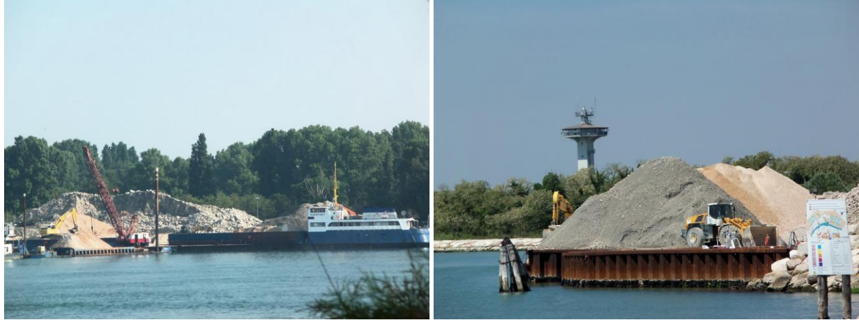
Figura 24: Foto delle attività sulla piarda di Alberoni. Carico pietrame sul pontone (sinistra, scattata il 19 Maggio 2011) e attività di un escavatore (destra, scattata il 10 Maggio 2011).
