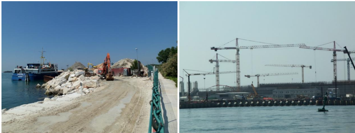
Figura 4: Foto della piarda di Alberoni (sinistra) e del cantiere della spalla Sud (destra), scattate il 19 Maggio.
