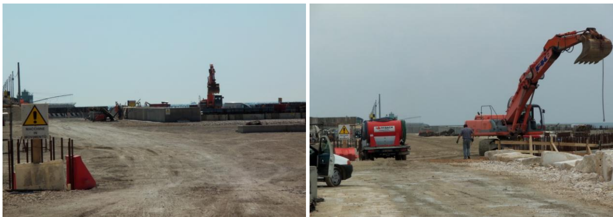
Figura 5: Foto del cantiere della spalla Nord scattate il 10 Maggio (sinistra) e il 21 Giugno 2011 (destra).
