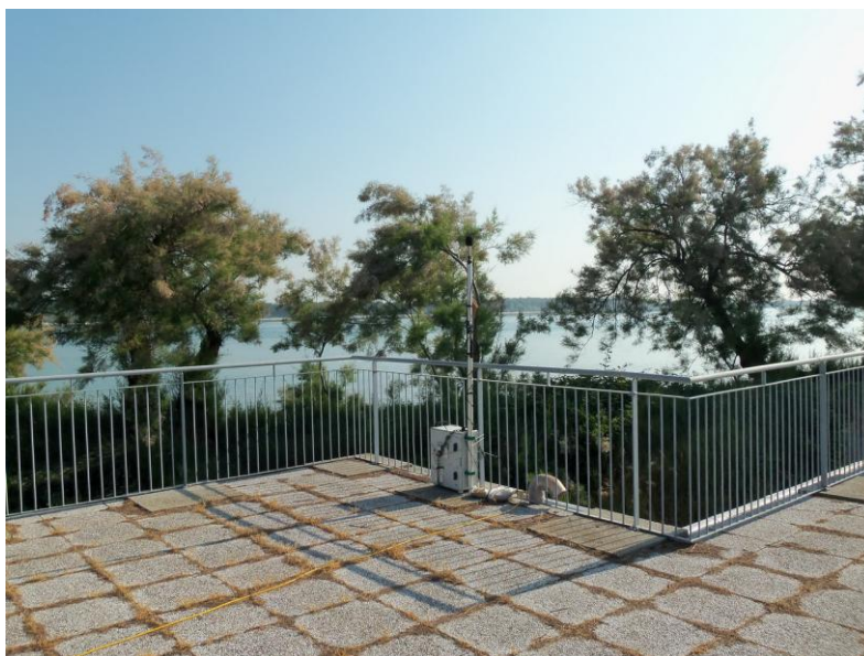
Figura 23: foto della centralina di monitoraggio.
