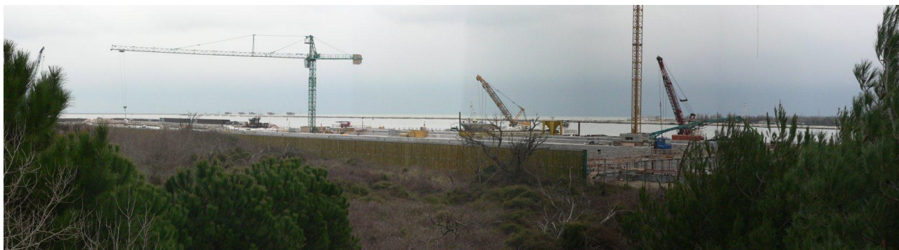
Fig. 2: Veduta d'insieme del cantiere (26-1-2007) dalla postazione CAROMA1 a circa 4 m di altezza dal suolo
