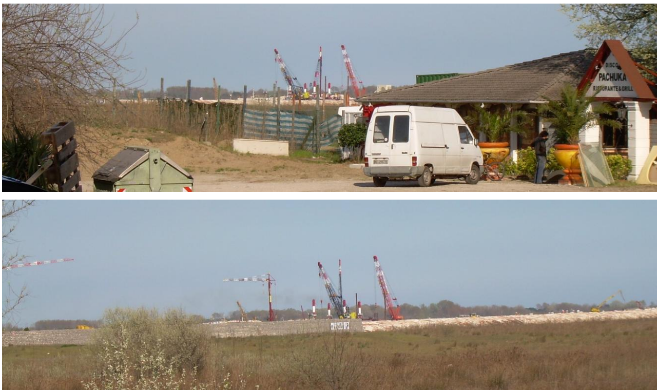
Fig. 7: Veduta d'insieme del cantiere (05-4-2007) dalle postazioni SNICOL2 e SNICOL5 rispettivamente, a circa 4 m di altezza dal suolo.
