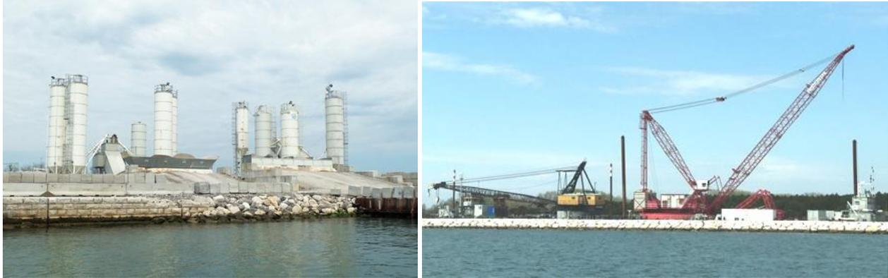
Figura 16: Foto dell'impianto di betonaggio e di due motopontoni posizionati nella zona di ormeggio. Immagini scattate il 16 Aprile.
