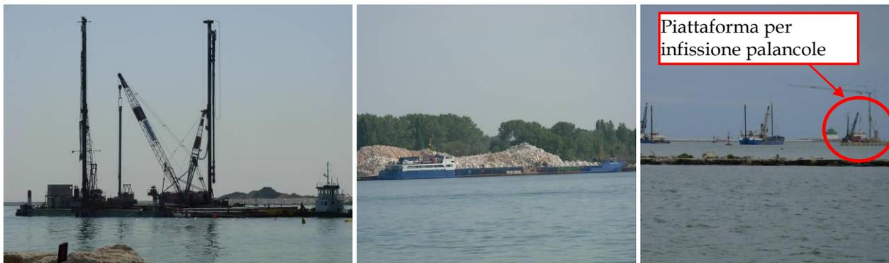
Figura 66: Foto del pontone con le macchine battipalo (a sinistra), dell'attività sulla piarda (al centro) e della piattaforma per l'infissione di palancole (a destra).
