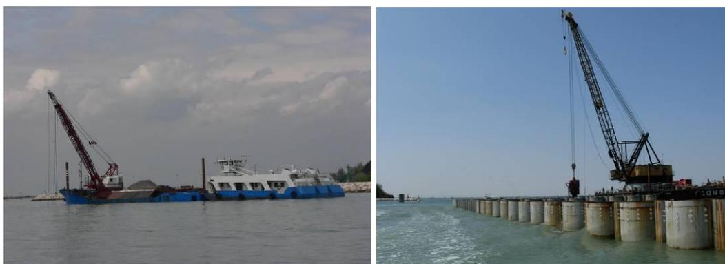
Figura 107: foto della motonave per il dragaggio del fondale e della gru per l’infissione palancole.
