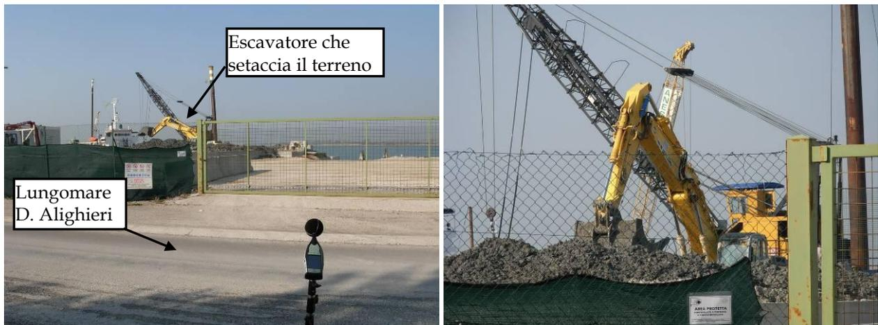
Figura 8: foto della postazione di misura breve (a sinistra) e particolare dell'attività di setacciatura (a destra).
