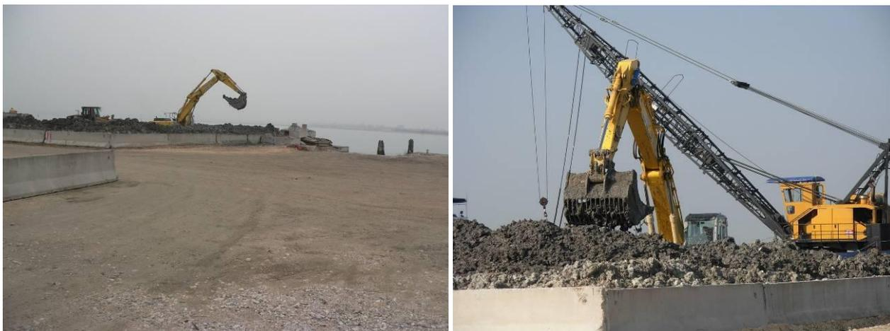
Figura 4: foto dell'attività di setacciatura terreno effettuata da un escavatore situato nel cantiere di Punta Sabbioni, scattate il 14 Febbraio (a sinistra) e il 25 Febbraio 2011 (a destra).
