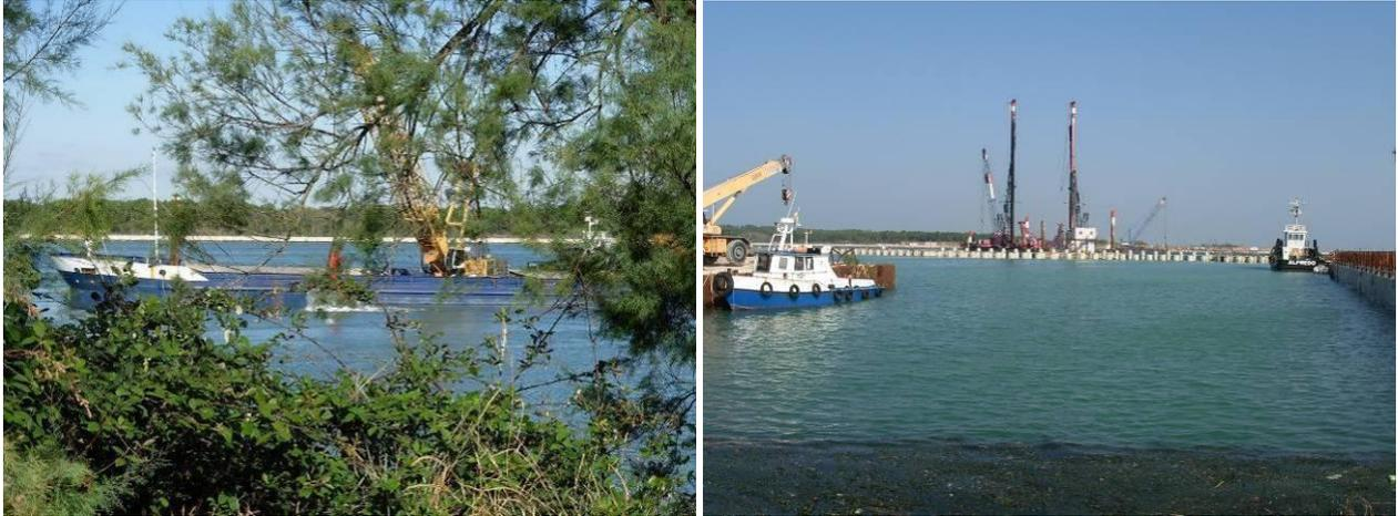
Figura 77: foto della motonave con piattaforma a ragno per il dragaggio del fondale, scattata il 7 Ottobre 2010 dalla terrazza della casa di riposo (sinistra); foto della macchina battipalo vista dal cantiere di Santa Maria del Mare, scattata il 15 Ottobre 2010 (destra).
