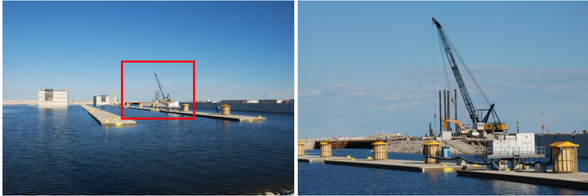
Figura 16: Foto del bacino di prefabbricazione (a sinistra) con evidenziata e ingrandita (a destra) l'area di rimozione delle palancole. Immagini scattate il 16 Aprile 2014.
