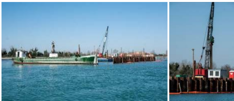
Figura 5: Foto dell'area del cantiere parzialmente perimetrata da palancole (a sinistra) e foto del vibroinfissore in azione agganciato ad una palanca (a destra). Immagini scattate il 24 Febbraio 2014.
