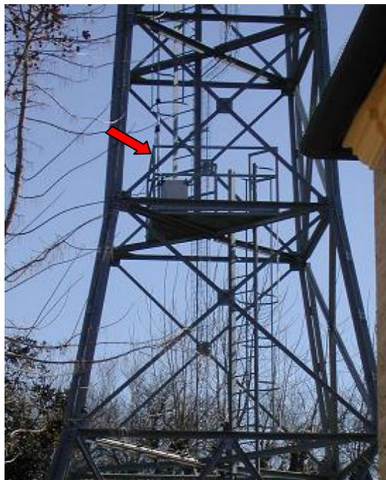
**Figura 13. Posizionamento centralina sulla torre rilevamento idrografico, punto rilievo SNICOLA.**
