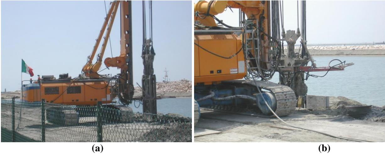
Figura 1. (a) Macchina BAUER BG 28 utilizzata per l'esecuzione dei diaframmi plastici; (b) particolare fresa perforatrice.
