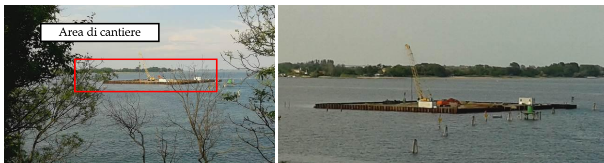
Figura 1: Foto della centralina di misura; foto della zona di cantiere (a sinistra); foto dell'isola provvisoria con macchinari per le attività (a destra) (foto scattate il 25 maggio 2015).
