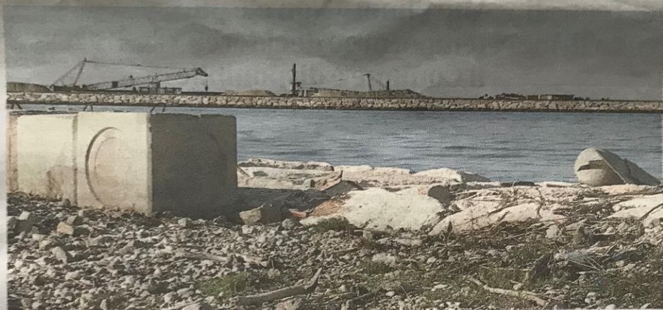
I cantieri del Mose a Chioggia nell'aprile dello scorso anno
