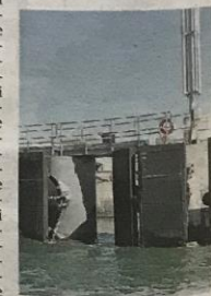
MOSE La posa delle barriere alle bocche di porto
